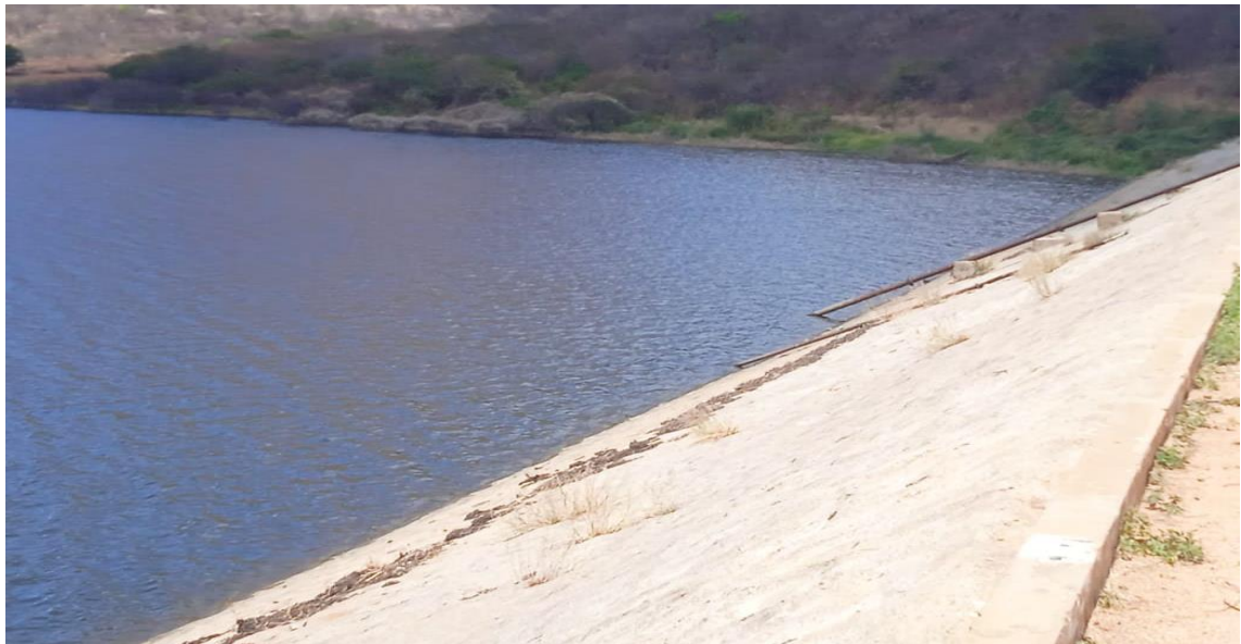
Figura 7 -Parede do Açude Lucrécia/RN após a reforma.
