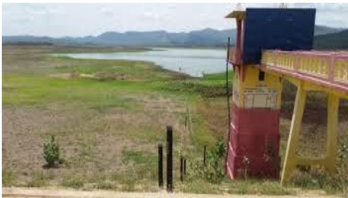
Figura 6- Aparecimento das réguas e torre em virtude do colapso do Açude Lucrécia em 2017.
