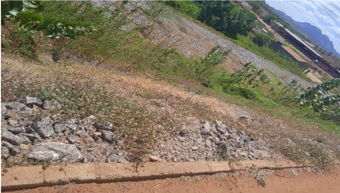
Figura 8- Enrocamento na parede do Açude.
