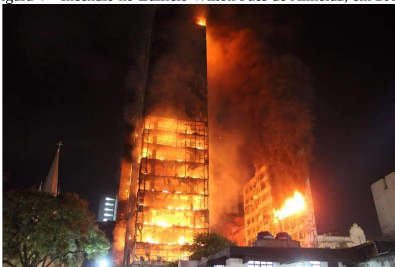
Figura 4 – Incêndio no Edifício Wilton Paes de Almeida, em 2018.
