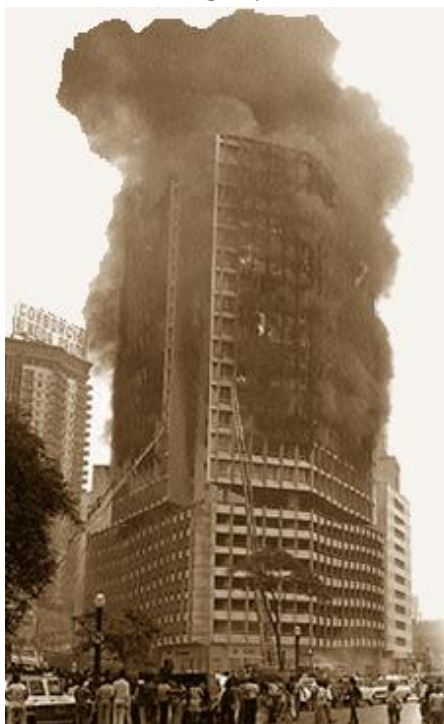
Figura 2 - Incêndio no Edifício Andraus, 1972.
