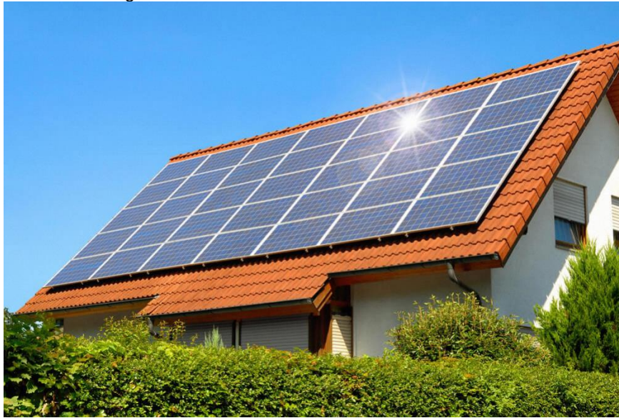
Figura 14 - Módulos Fotovoltaicos Concentrados
