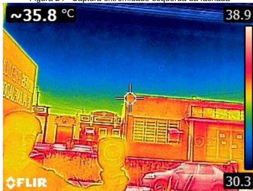
Figura 24 - Captura extremidade esquerda da fachada
