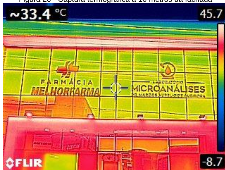
Figura 20 - Captura termográfica a 10 metros da fachada
