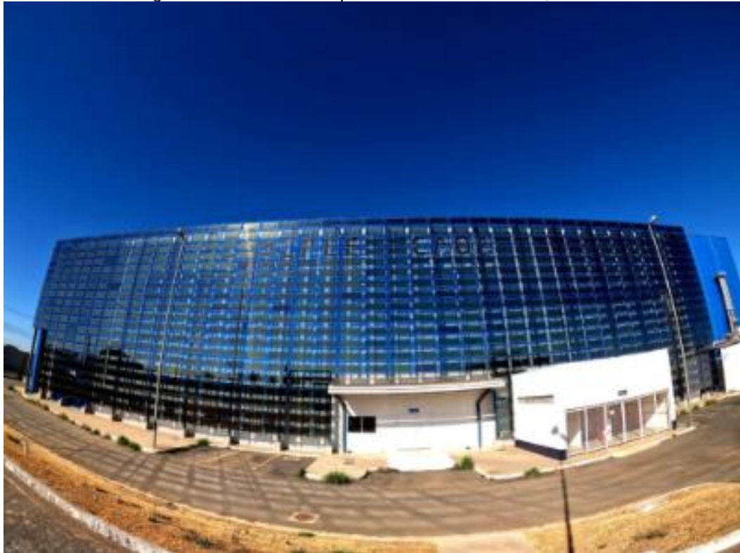
Figura 13 - Edifício com placas solares em Goiás, Brasil.
