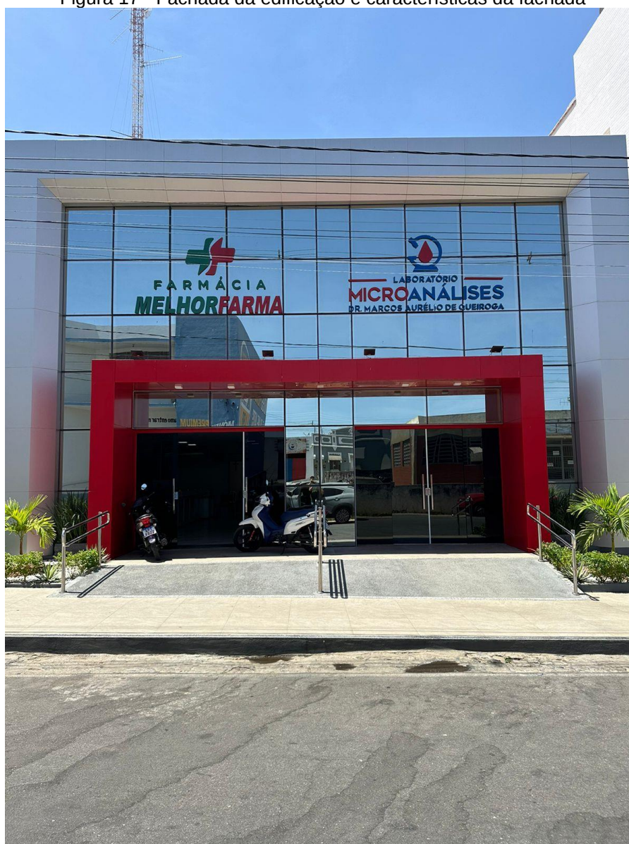
Figura 17 - Fachada da edificação e características da fachada
