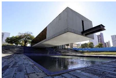
Figura 5: Viga em balanço - Mausoléu Castello Branco. Fonte: [12]
