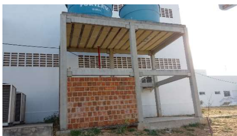
Figura 7: Viga de Gerber - Estrutura de apoio para reservatório de água – UFERSA.
