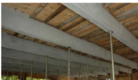
Figura 3: Viga de concreto armado. Fonte: [10]
