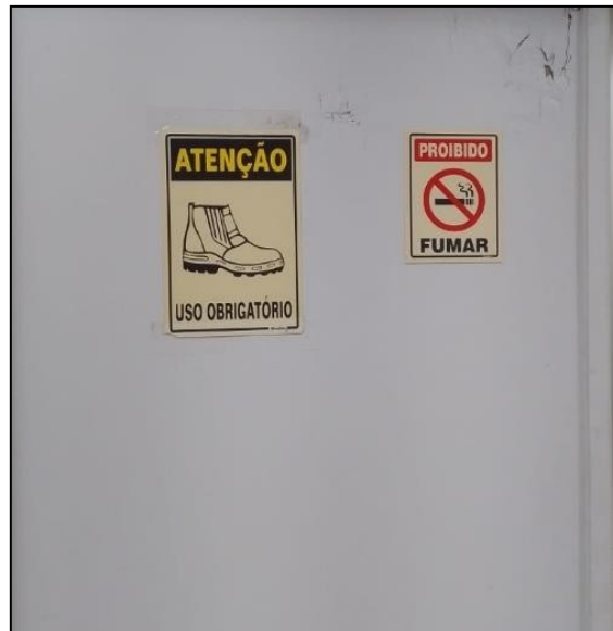
Figura 21 - Placas de sinalização.
