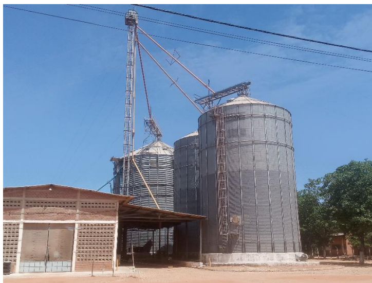
Figura 1: Silos verticais da fábrica de ração
