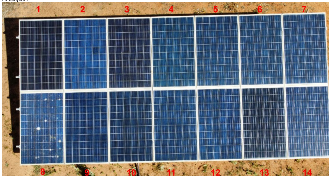
Figura 3: Inspeção visual com drone. (Fonte: Autoria própria)
