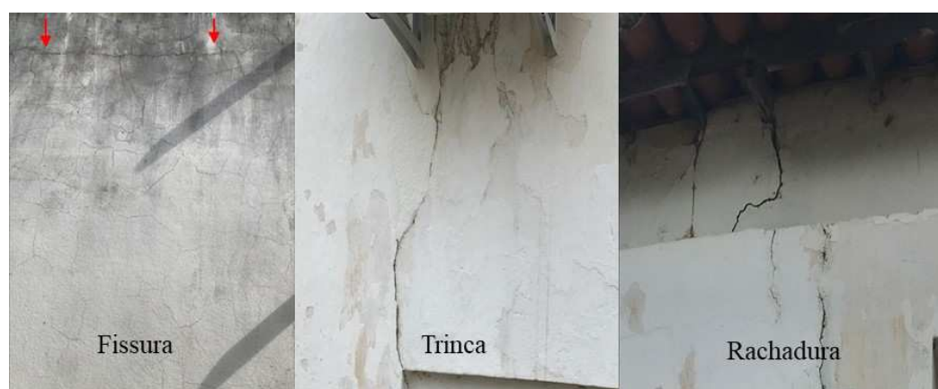
Figura 2 : Características de fissuras, trincas e rachaduras
