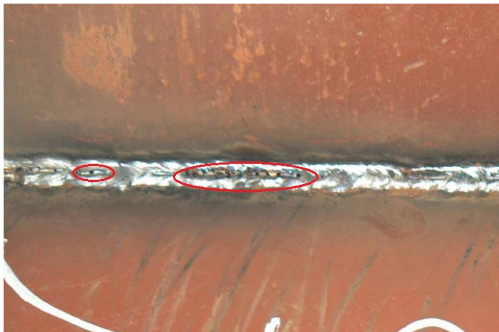
Figura 02 – Poros em juntas soldada.
