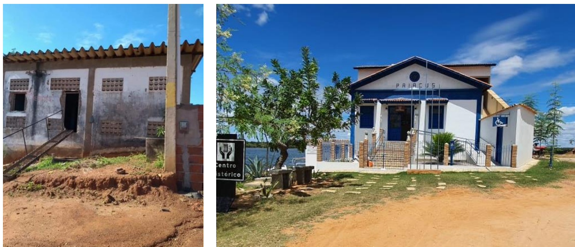
Figura 7: Prédio do Museu do Índio Luiza Cantofa – Centro Histórico Cultural Tapuia Paiacu da Lagoa do Apodi, antes e depois da reforma.
