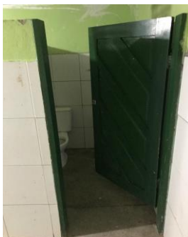
Figura 32 - Disposição de porta no banheiro do Clube Municipal
