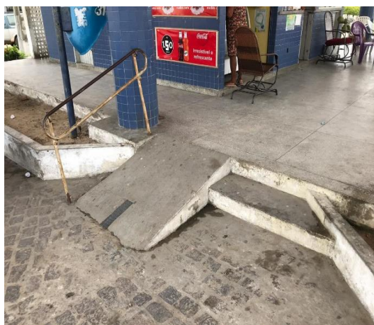
Figura 38 - Rampa e degrau de acesso para a Rodoviária Municipal
