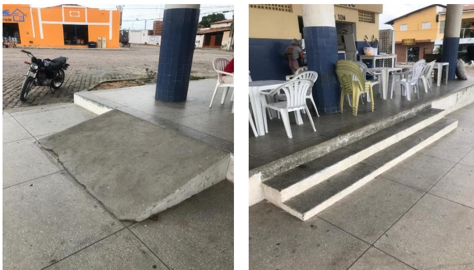
Figura 39 - Dispositivos para superar obstáculo interno da edificação
