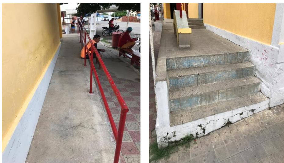
Figura 36 - Rampa e escada disposta para acesso a Sede da Prefeitura Municipal
