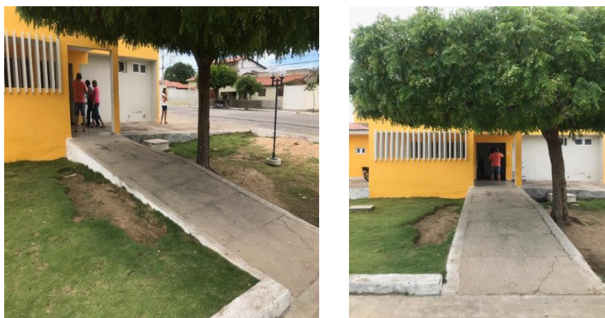
Figura 41 - Rampa para acesso principal do Hospital Municipal
