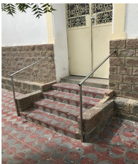
Figura 50 - Escada de acesso a Igreja Matriz
