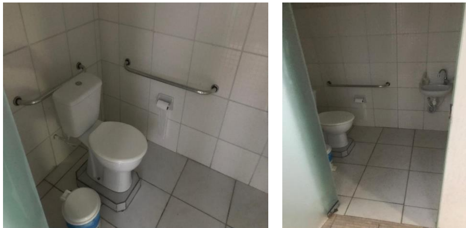
Figura 47 - Banheiro da Câmara Municipal
