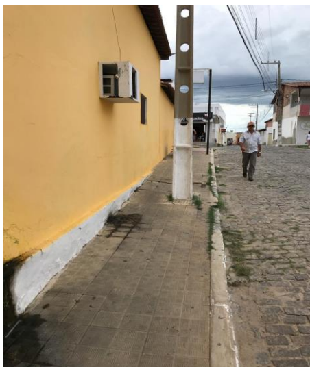
Figura 37 - Obstáculos na calçada lateral da Prefeitura
