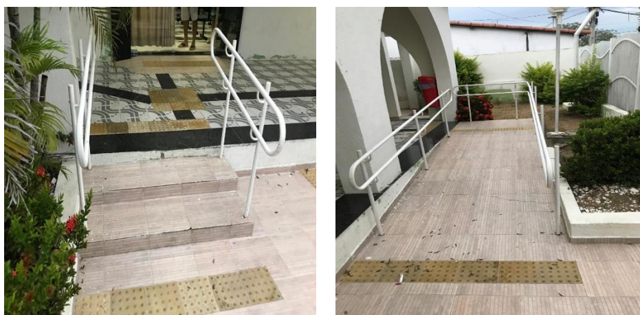
Figura 45 - Escada e rampa dispostas para acesso a Câmara Municipal
