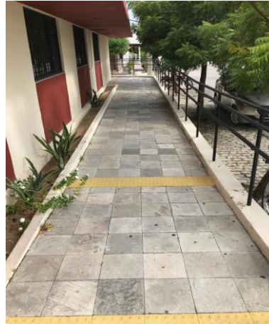
Figura 56 - Rampa de acesso ao Fórum de Angicos
