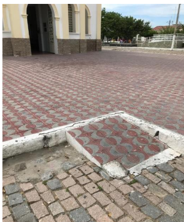
Figura 49 - Rampa de acesso para calçada da Igreja Matriz
