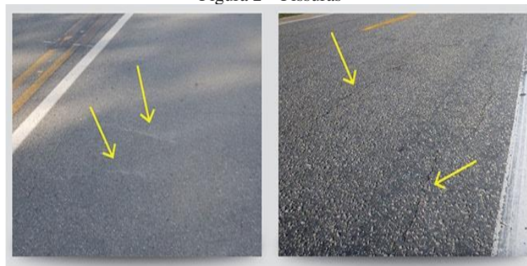
Figura 2 – Fissuras
