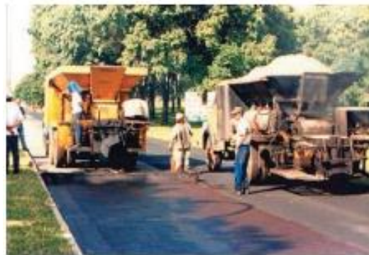
Figura 10 – Aplicação de lama asfáltica
