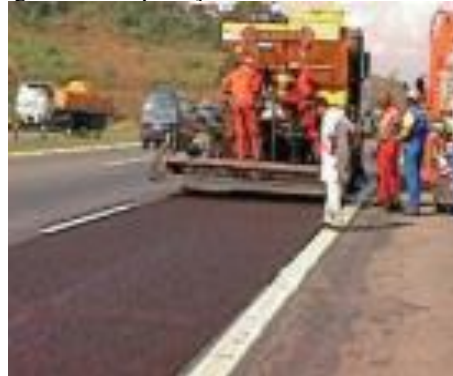
Figura 11 – Aplicação do microrrevestimento
