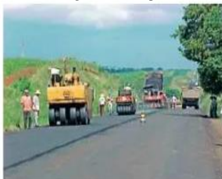
Figura 9 – Recapeamento
