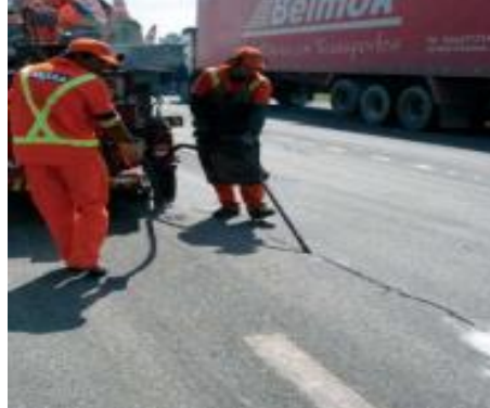
Figura 12 – Aplicação da selagem de trincas
