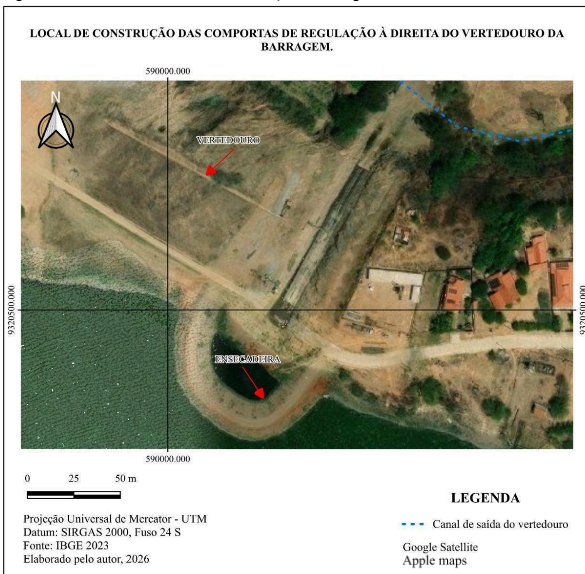
Figura 20 - Vista aérea do local de intervenção na barragem de Pau dos Ferros/RN
