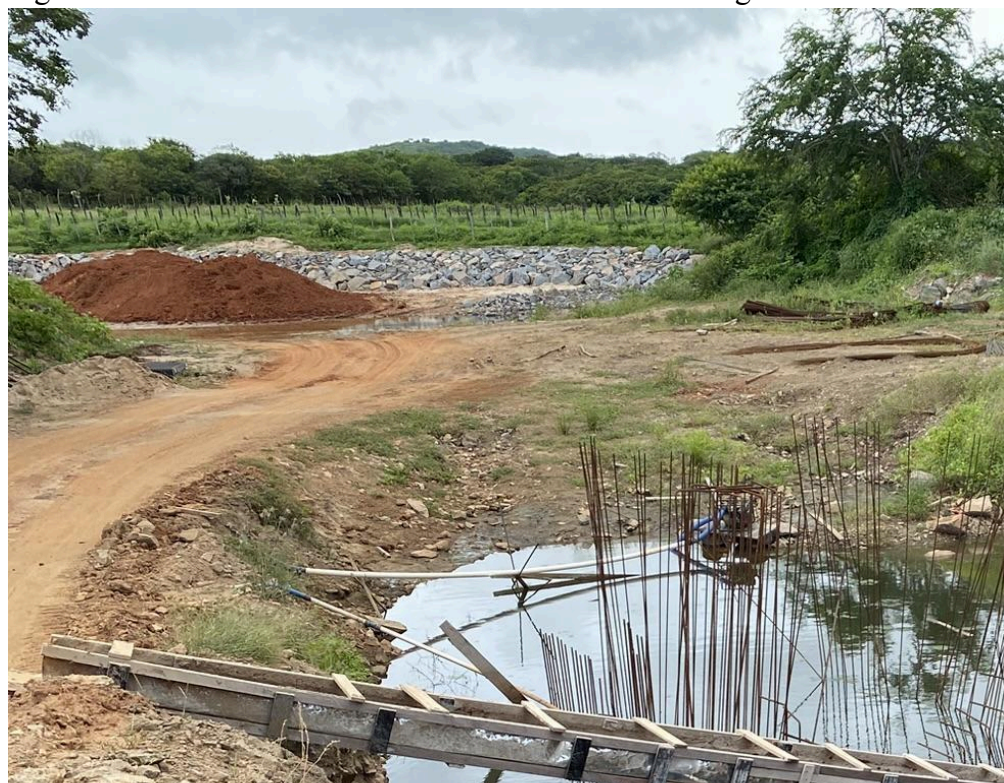
Figura 25 - Enrocamento ao final da saída da tomada d'água
