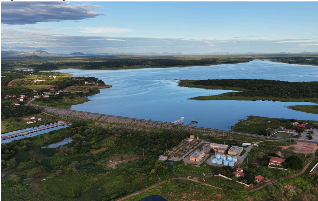
Figura 8 - Barragem de Pau dos Ferros/RN maio de 2026
