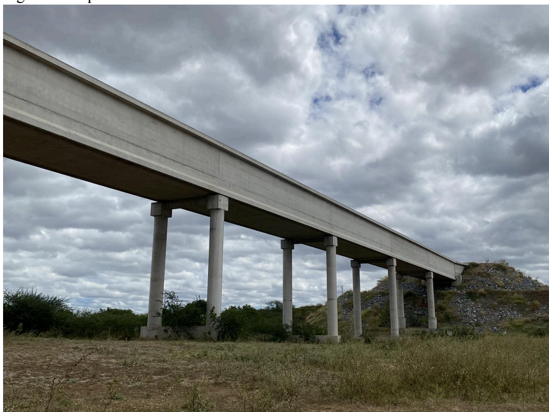
Figura 1 - Aqueduto sobre riacho localizado em Cachoeira dos Índios/PB
