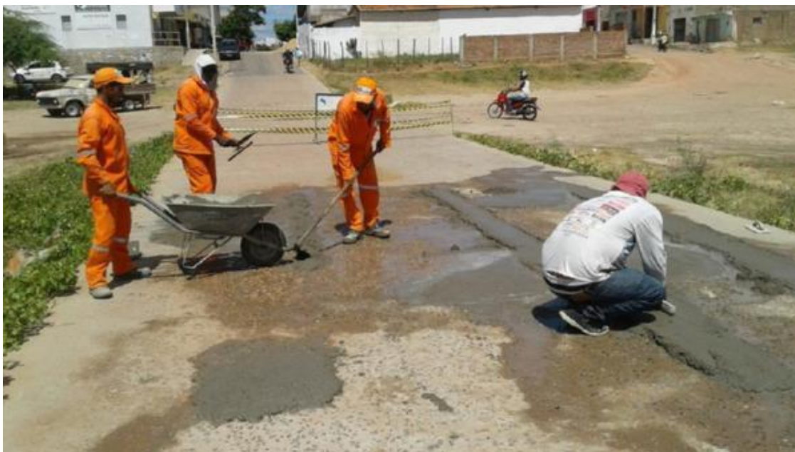
Figura 34 - Recuperação do pavimento da passagem molhada da Rua Antônio Gurjão no Bairro São Geraldo em Pau Dos Ferros/RN
