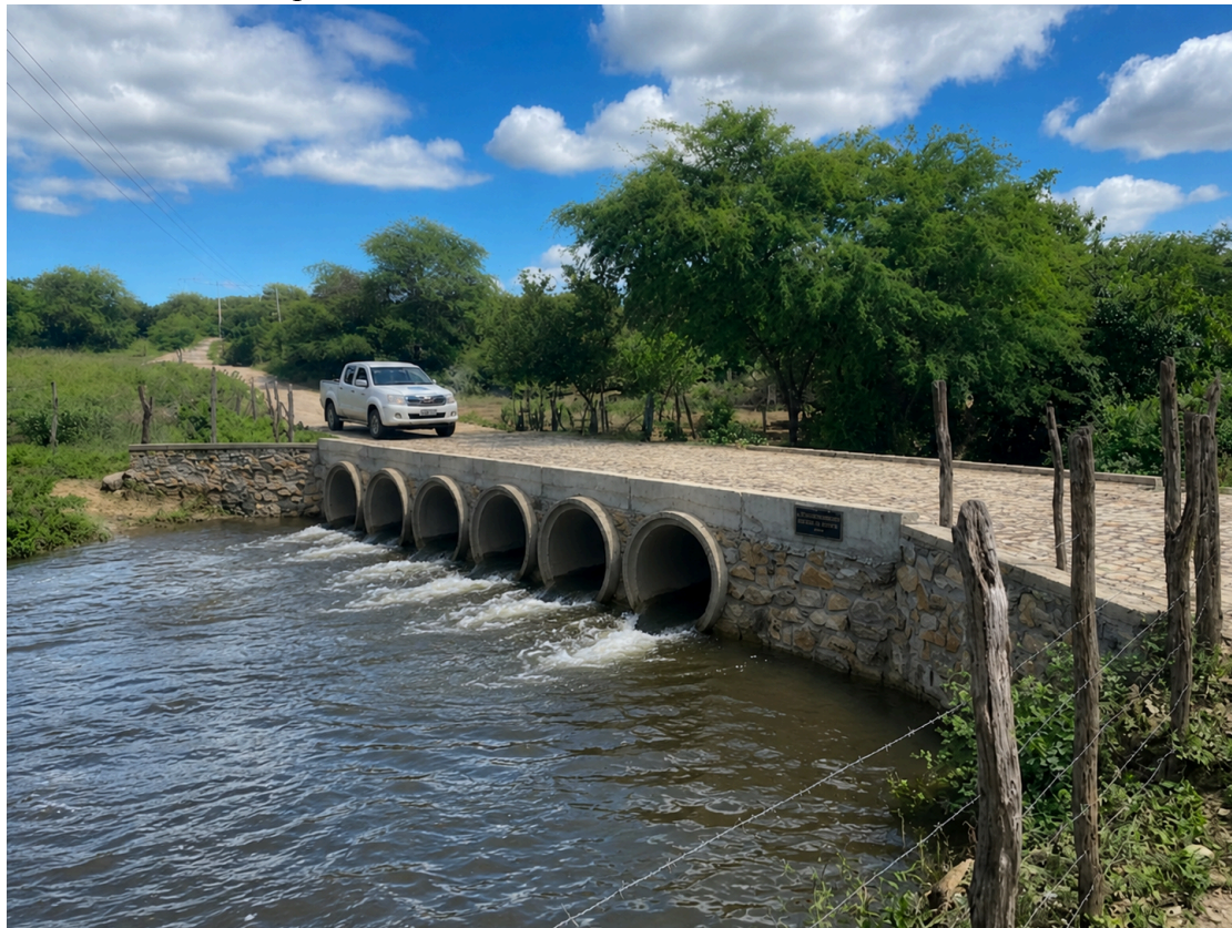
Figura 11 - Simulação da implantação de uma passagem molhada em travessia rural localizada no município de Pau dos Ferros
