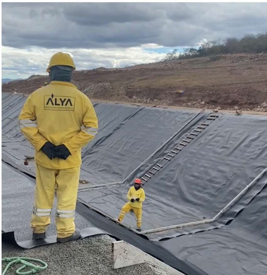
Figura 4 - Construção dos canais do eixo norte, trecho na cidade de Uiraúna/PB
