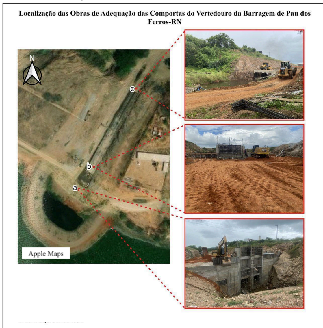
Figura 24 - Vista de satélite da área de implantação das comportas da Barragem de Pau dos Ferros-RN, com indicação dos principais elementos da obra e registro fotográfico das estruturas em construção
