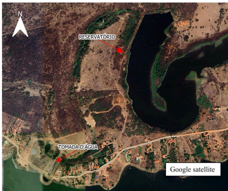
Figura 28 - Vista de satélite do reservatório situado a montante da tomada d'água
