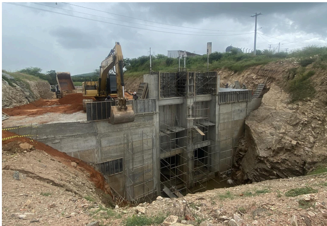
Figura 22 - Construção das comportas à direita do vertedouro da Barragem de Pau dos Ferros/RN
