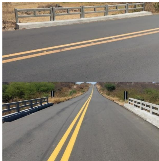
Figura 17: Juntas de dilatação cobertas pelo pavimento.
