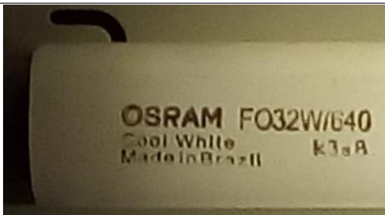
Figura 5: Especificações da lâmpada utilizada na Central de aulas VI (autoria própria).
