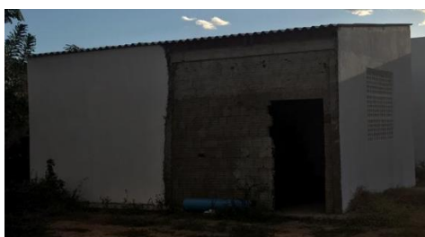
Casa de máquinas
