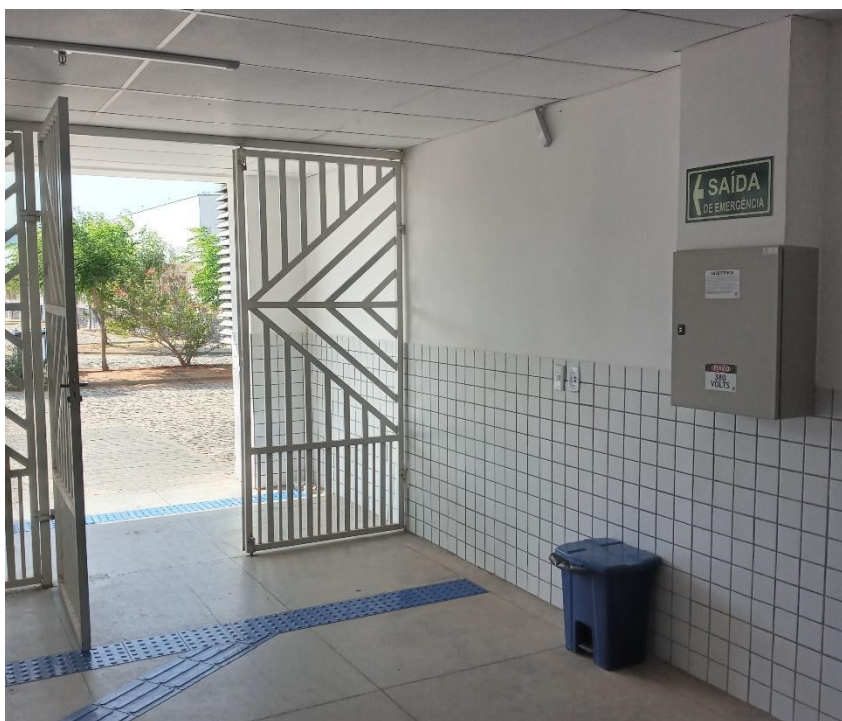
Figura 26 – Saída de Emergência no Pavimento de Descarga
