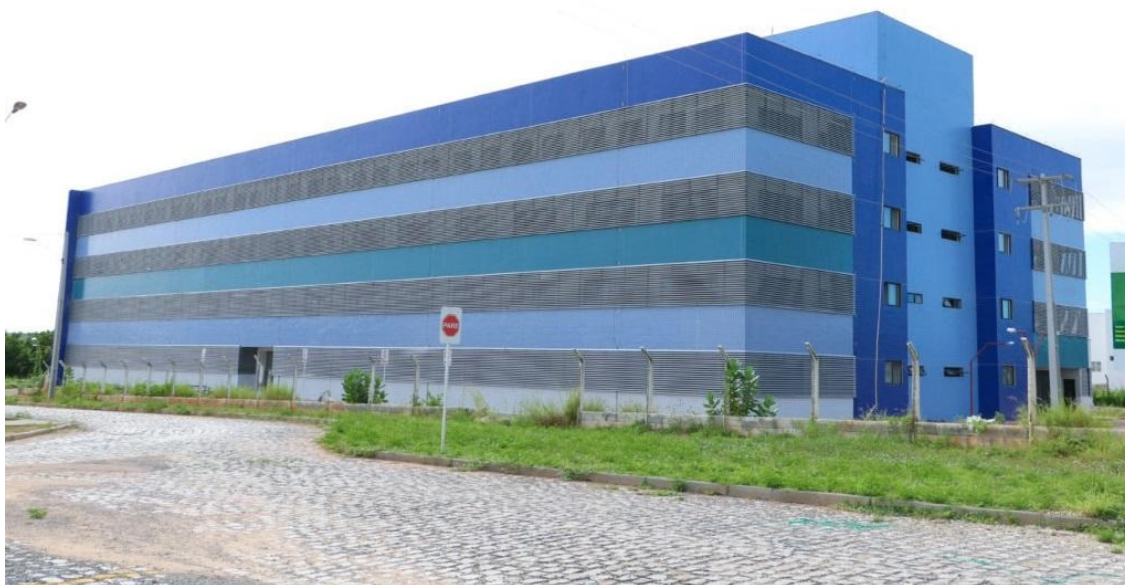
Figura 18 – Vista da edificação em estudo
