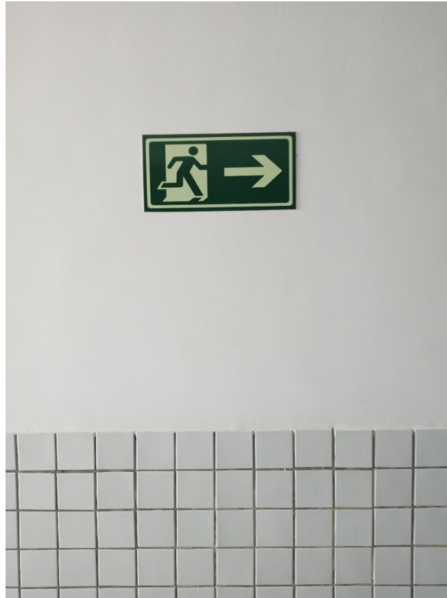
Figura 27 – Sinalização da saída de emergência
