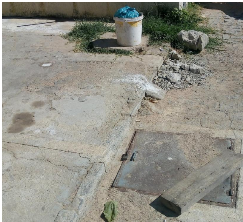
Figura 19 - Poço nº 9 localizado próximo a uma possível fonte de contaminação.
