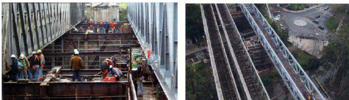
Figura 20: Substituição das pontes ferroviárias metálica, em Oeiras.
