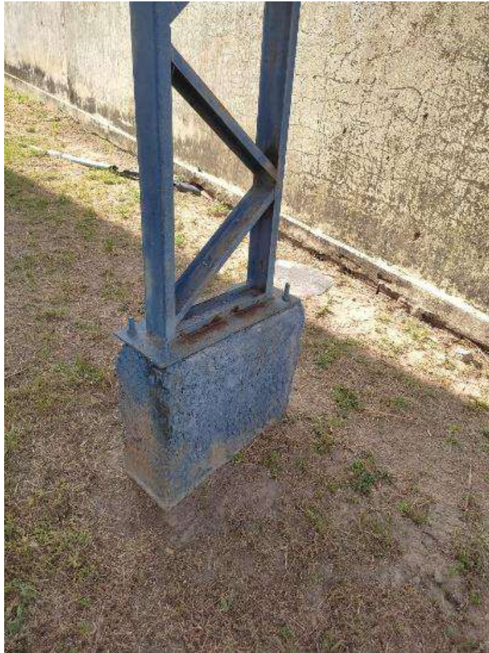
Figura 12: Pilar que constituem a cobertura metálica.
