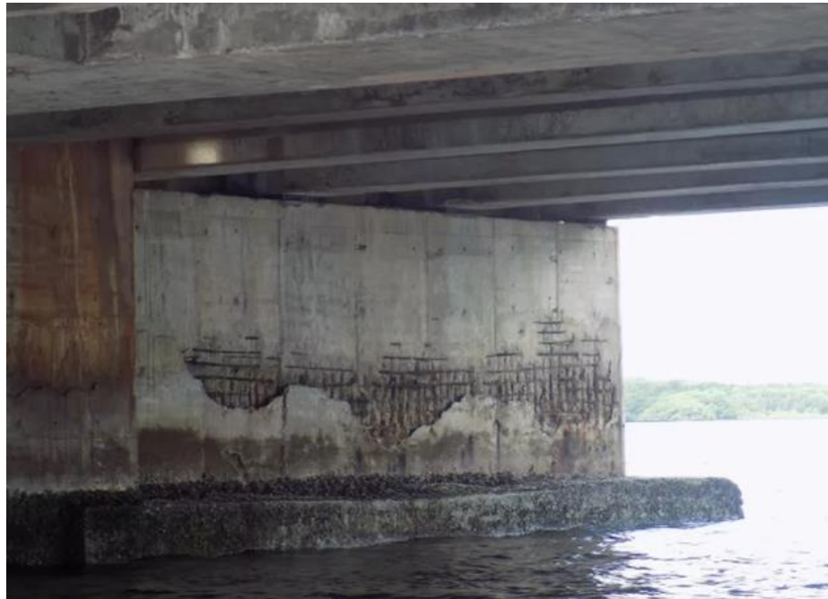
Figura 3 - Estrutura de concreto armado da ponte de Igapó-Natal/RN.
