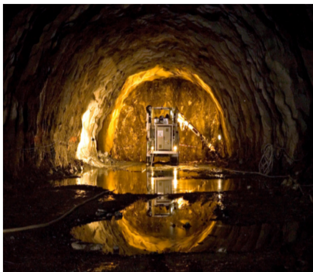
Figura 9 - Estrutura subterrânea, perfuração de túnel
