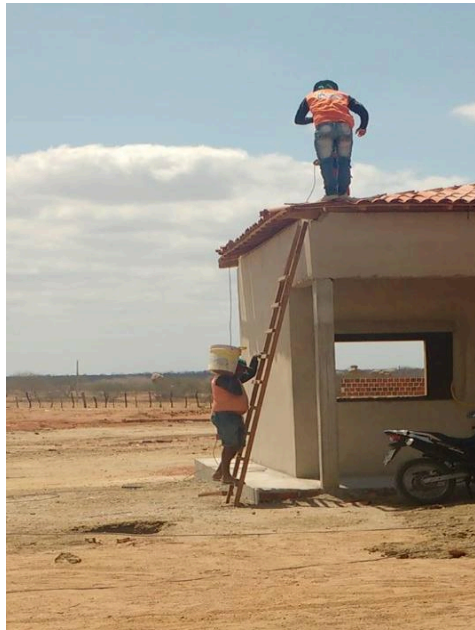
Figura 5 – Trabalho em Altura
