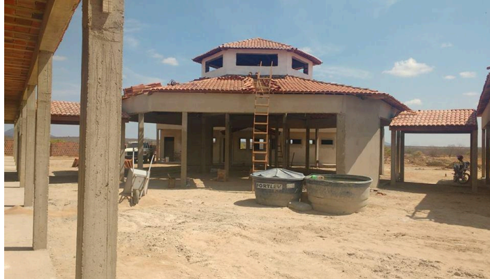
Figura 8 – Vista lateral direita do canteiro de obras
