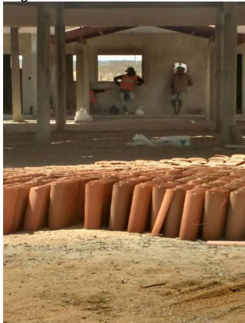
Figura 9 – Trabalho a céu aberto
