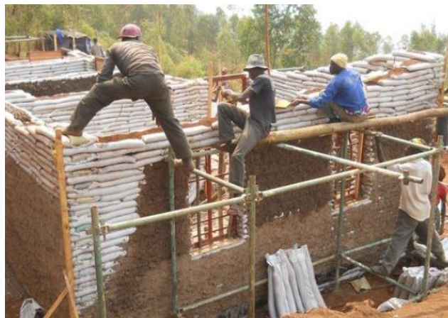
Figura 6 – Execução do reboco de uma parede feita com superadobe
