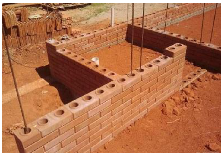
Figura 8 – Alvenaria feita de tijolos solo cimento
