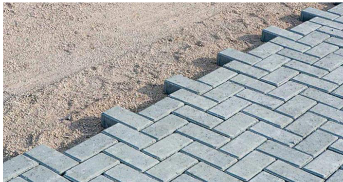
Figura 11 – Piso de blocos intertravados
