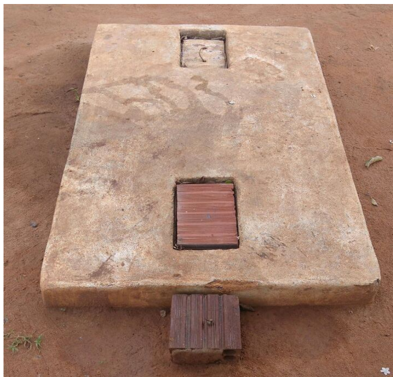
Figura 13. Vista superior do tanque séptico
