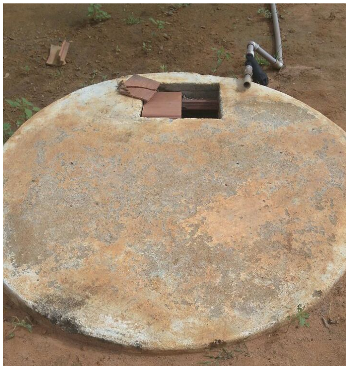
Figura 15. Vista superior do reservatório de armazenamento.
