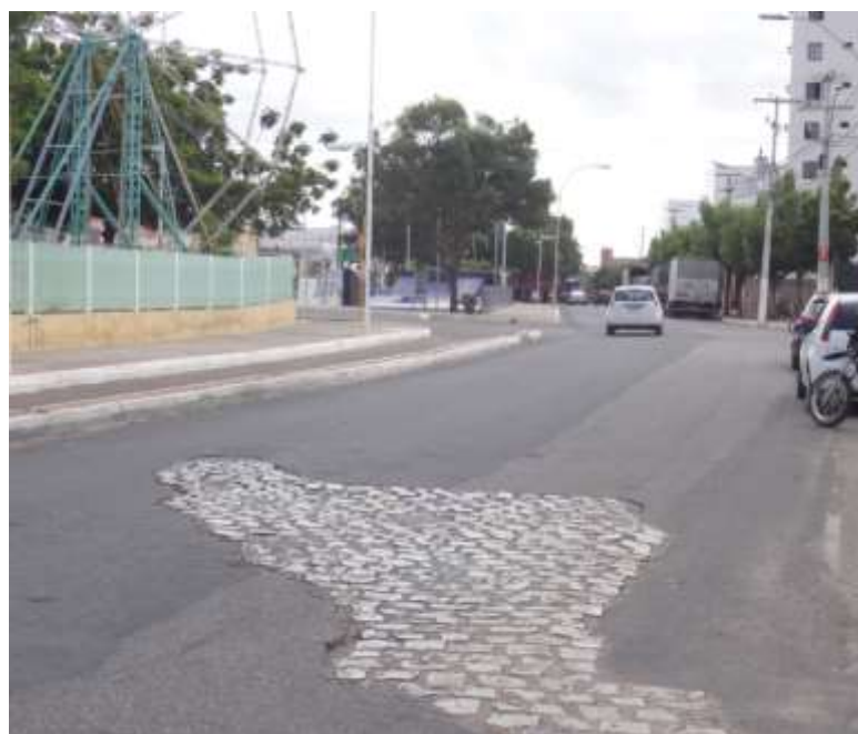
Figura 27 – Ponto de chegada
