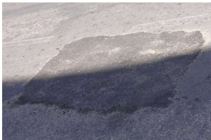
Figura 24 – Remendos superficiais
