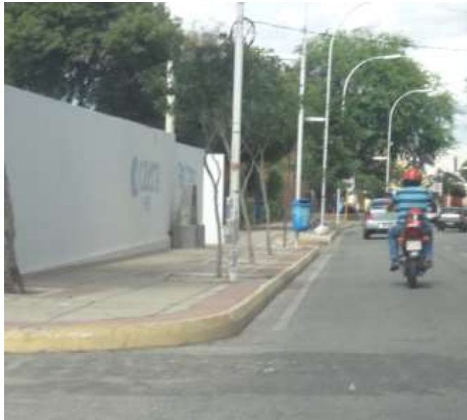
Figura 25 – Remendo superficial localizado
