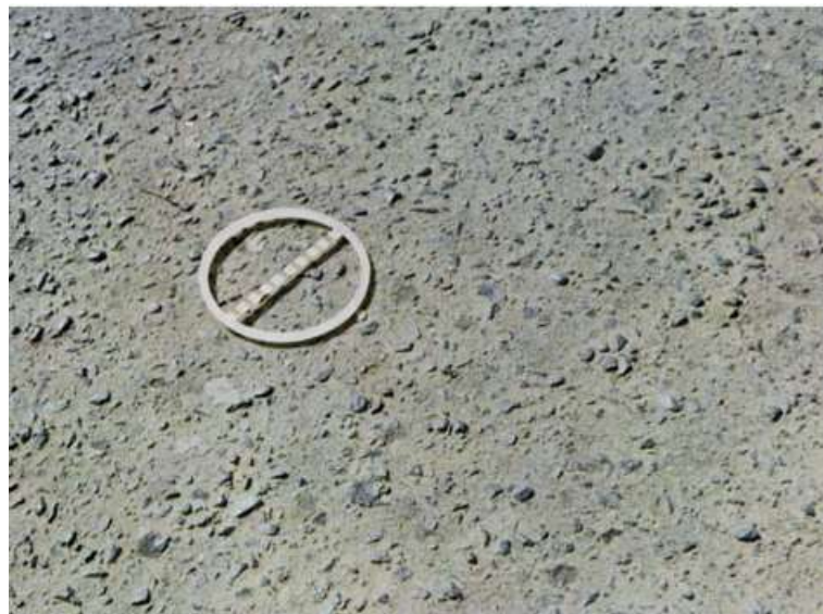
Figura 13 – Desgaste
