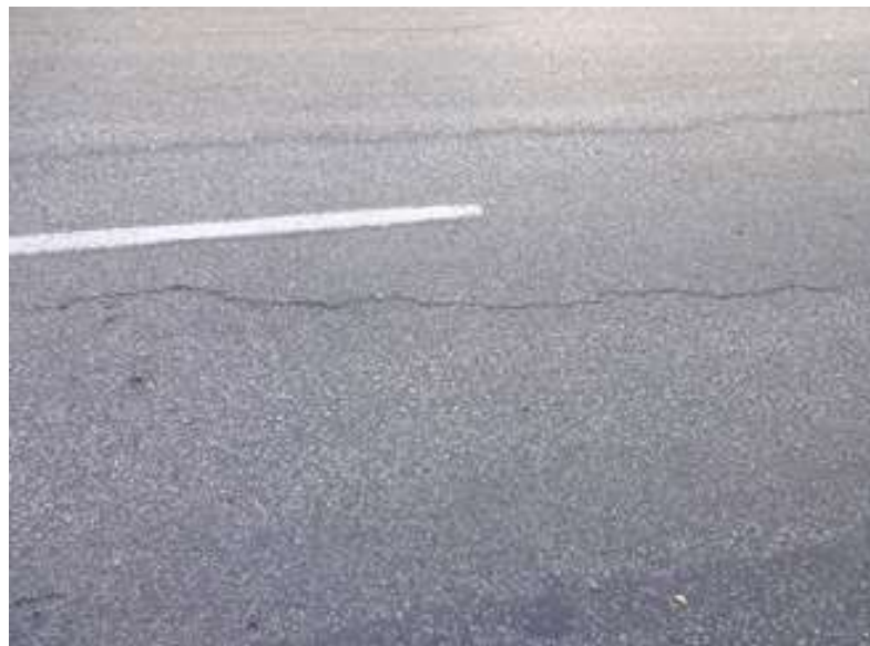
Figura 19 – Trincas longitudinais
