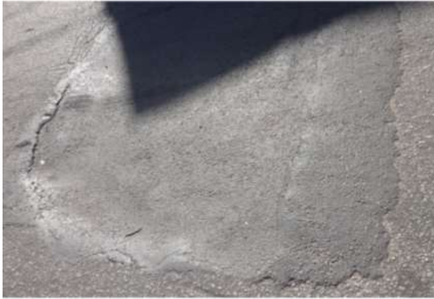
Figura 21 – Afundamento consolidado Local
