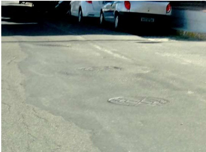
Figura 20 – Afundamento de consolidação de trilha
