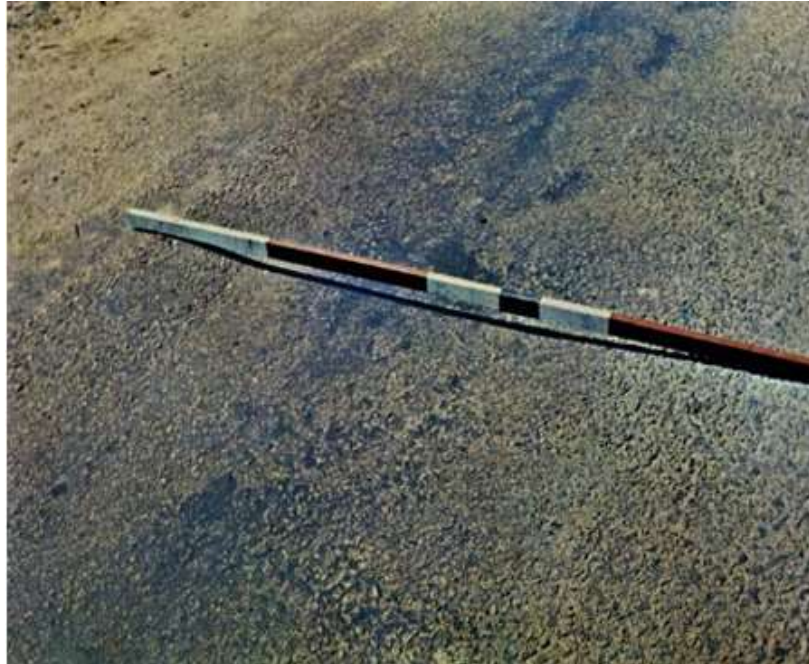
Figura 9 – Afundamento local
