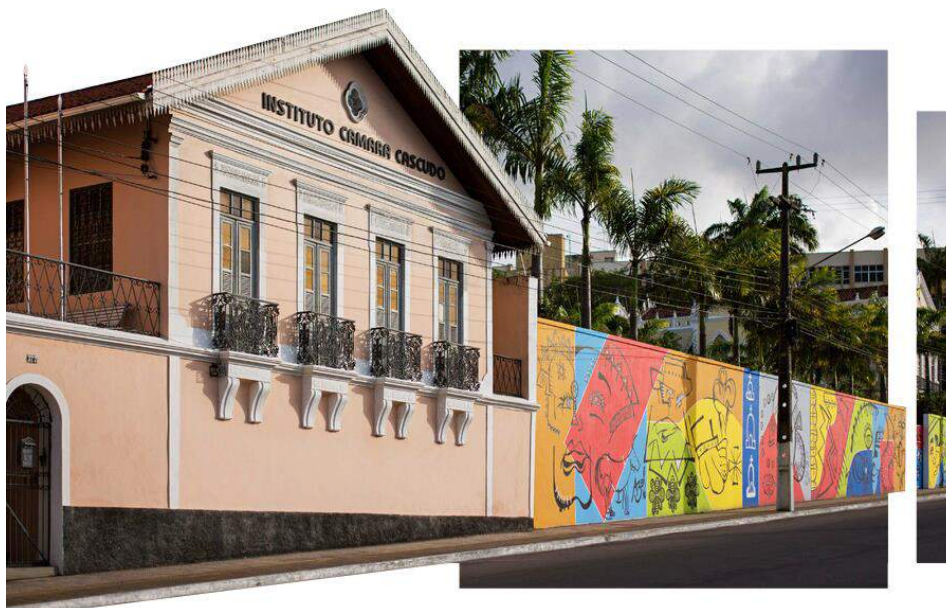
Figura 8 - Residência Camara Cascudo
