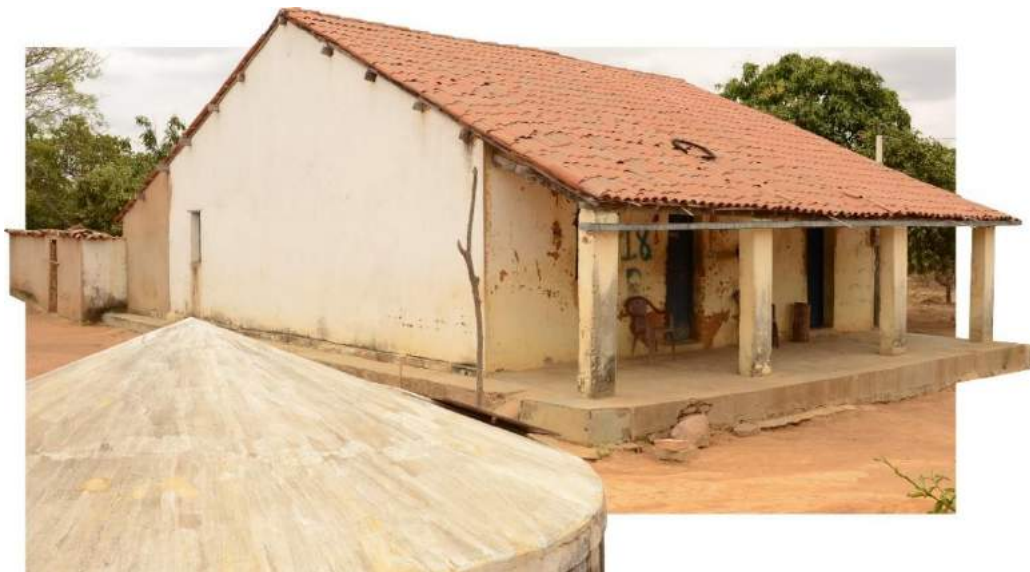
Figura 4 – Construção de alpendre na comunidade do Pêga
