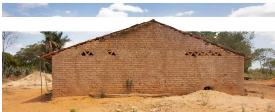
Figura 56 - Fotografia fachada lateral Casa de Farinha
