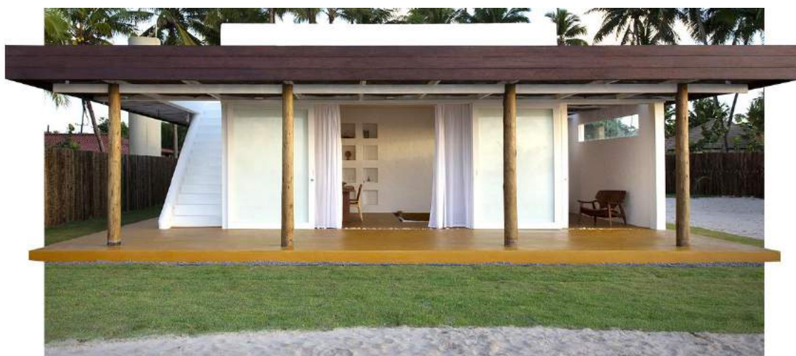
Figura 88 – Vista frontal Casa Cupe.
