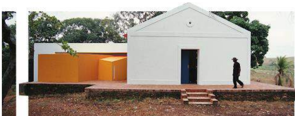
Figura 16 - Fachada frontal casa do Engenho Queira Deus
