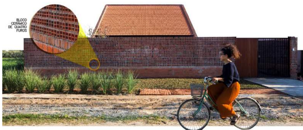
Figura 90 – Vista frontal muro da casa Long An.
