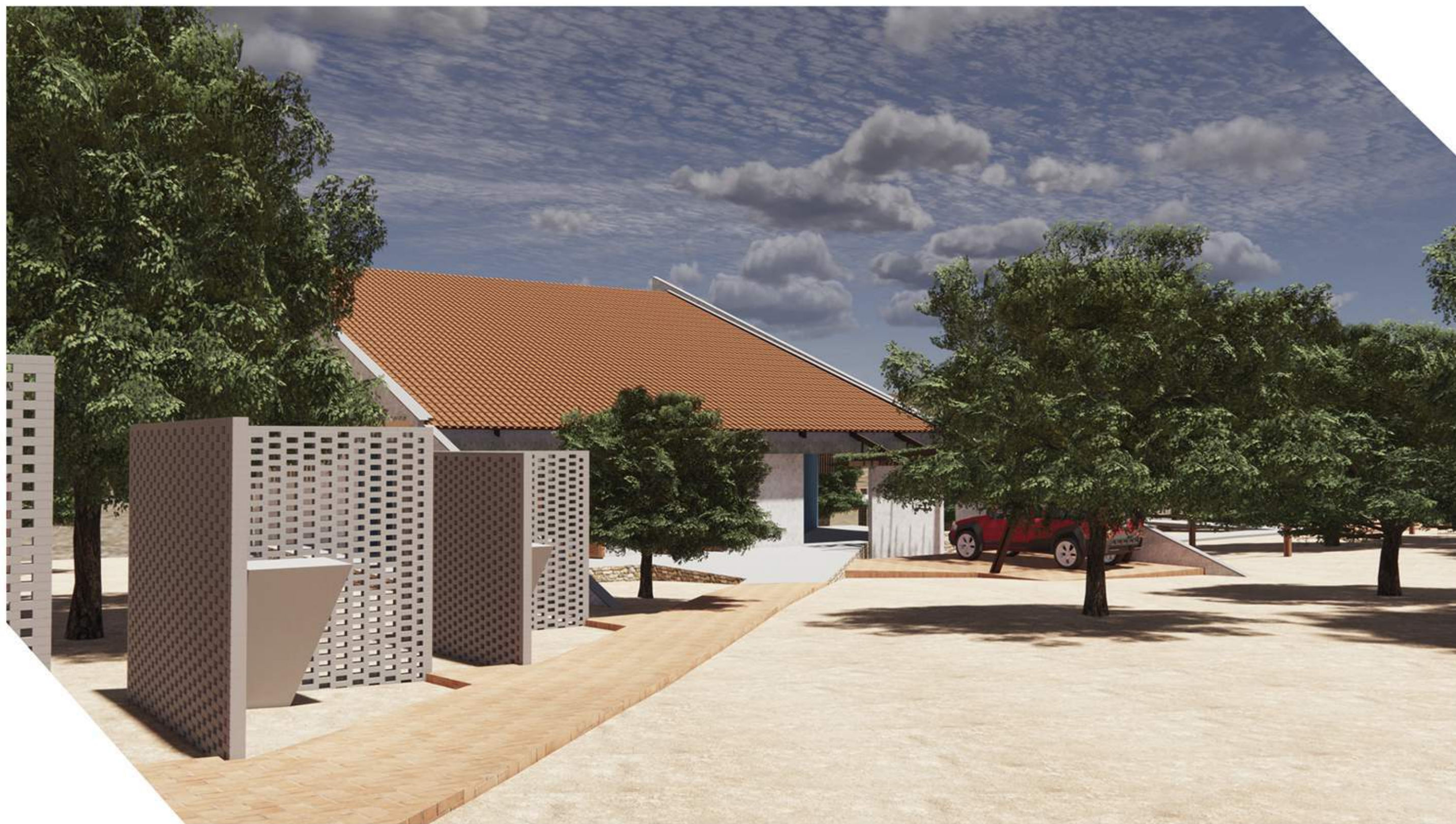
VISTA EXTERNA PAVILHÃO EXPOSITIVO
