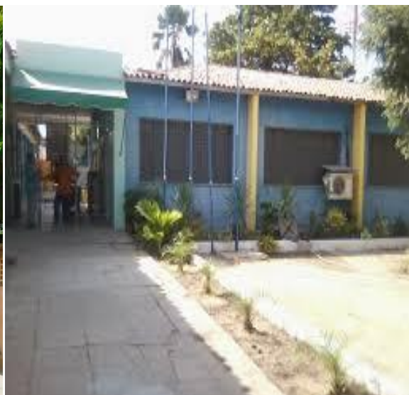
Figura 3- Fachada da Escola Lauro Rebouças
