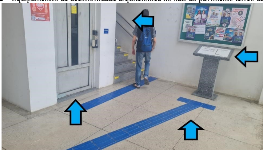
Figura 12 – Equipamentos de acessibilidade arquitetônica no hall do pavimento térreo da biblioteca
