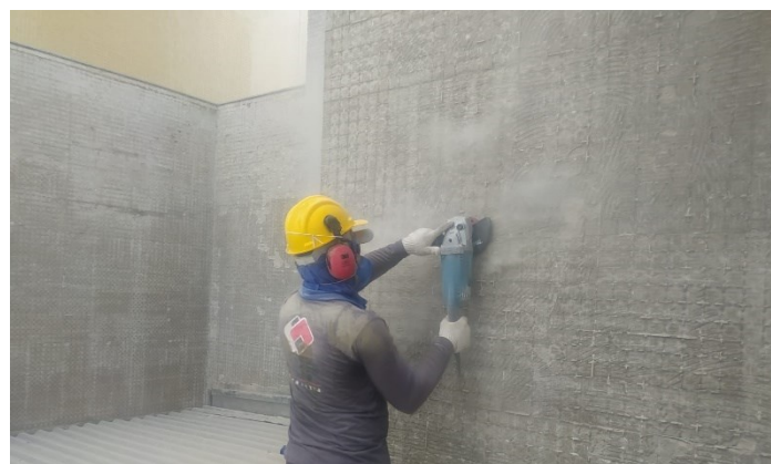
Figura 18 - Lixamento para retirada de excesso de argamassa.
