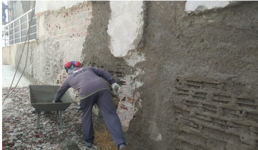
Figura 21 - Aplicação de Chapisco pronto.
