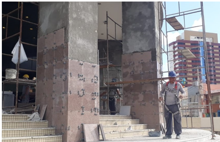
Figura 32 - Assentamento de pedras de granito dos pilares frontais.
