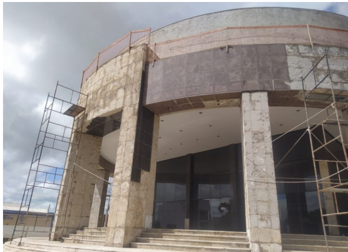
Figura 16 - Remoção do revestimento em granito.
