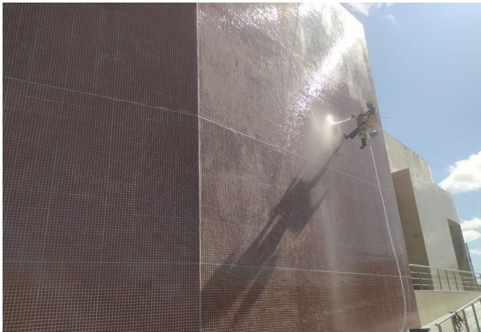
Figura 36 - Limpeza final das fachadas do Teatro Diux-Rosado, em Mossoró-RN.
