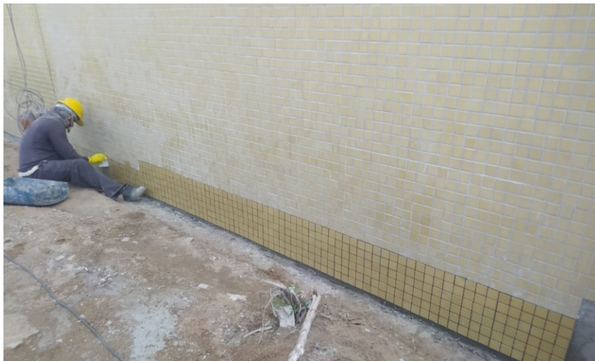
Figura 29 - Rejuntamento das pastilhas cerâmicas.
