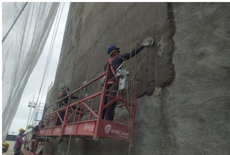
Figura 24 - Aplicação de emboço de regularização para o recebimento do revestimento.
