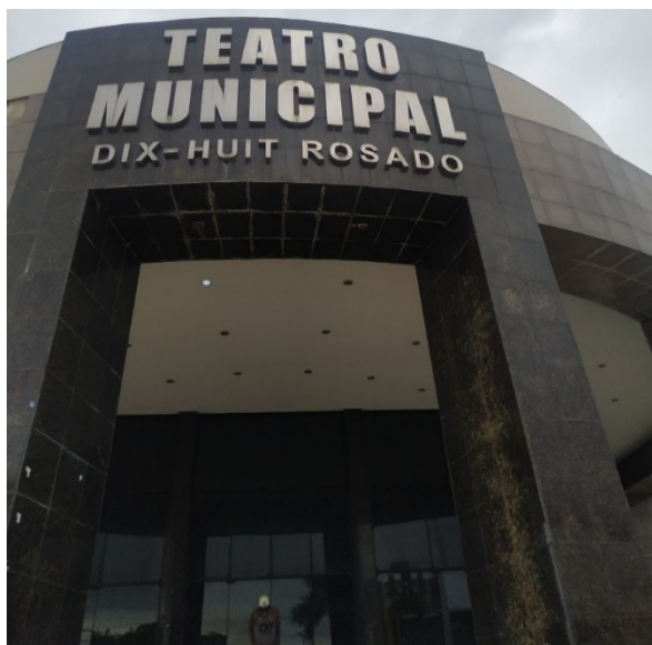
Figura 46 - Descamação de pedras de granito do Teatro Dix-Huit Rosado.
