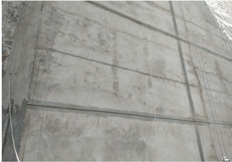
Figura 25 - Corte de juntas de dilatação para preenchimento com selante e delimitador de profundidade.
