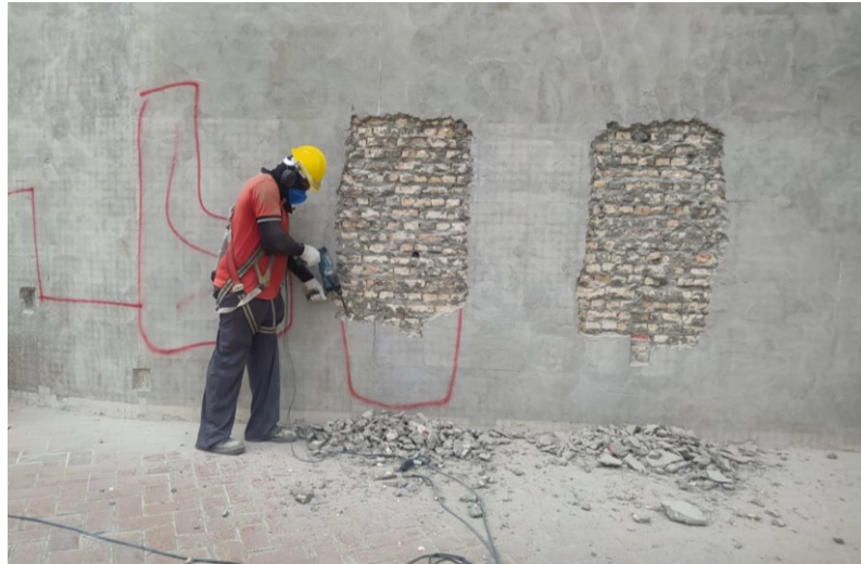
Figura 19 -. Mapeamento e remoção de áreas de emboço com patologias.
