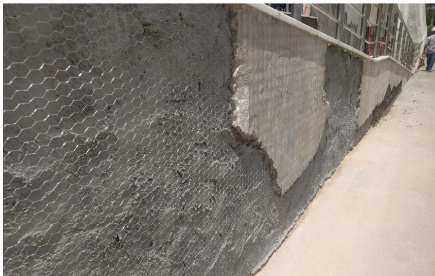
Figura 22 - Posicionamento de tela metálica após a aplicação da primeira camada de emboço.
