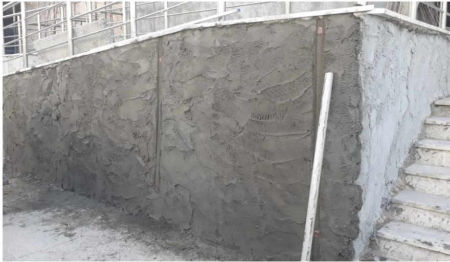
Figura 23 - Aplicação de segunda camada de emboço.
