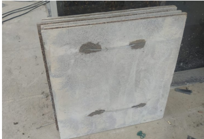
Figura 31 - Fixação de grampo em pedras de granito.
