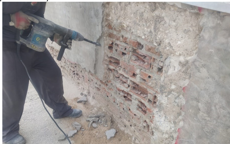
Figura 20 - Remoção de emboço com martelete.
