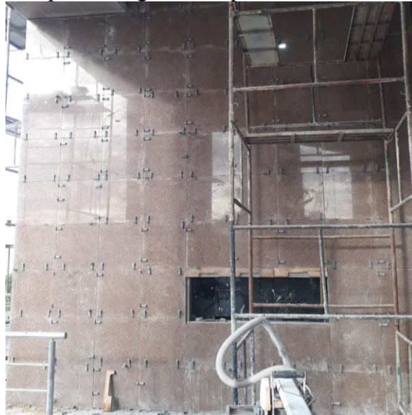
Figura 33 - Assentamento de pedras de granito na parede frontal interna.
