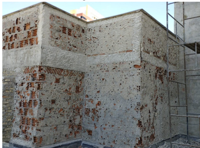
Figura 17 - Remoção de revestimento em pastilha cerâmica.
