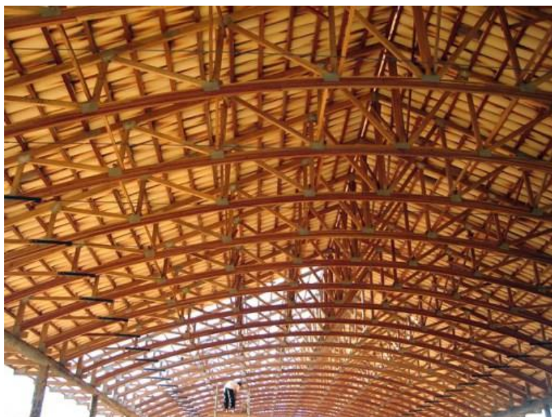
Figura 4 – Telhado de madeira
