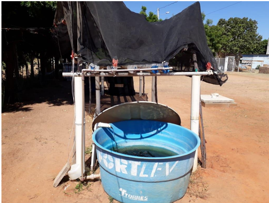
Figura 5: Caixa de armazenamento da água que sai dos filtros.
