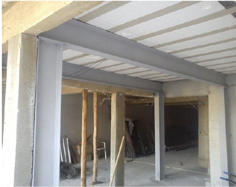
Figura 5: Reforço com perfis metálicos
