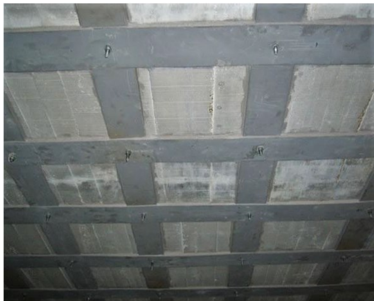
Figura 4: Laje reforçada com chapas metálicas
