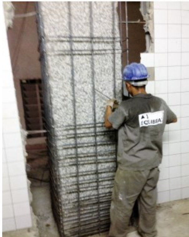
Figura 2: Adição de armaduras em pilar
