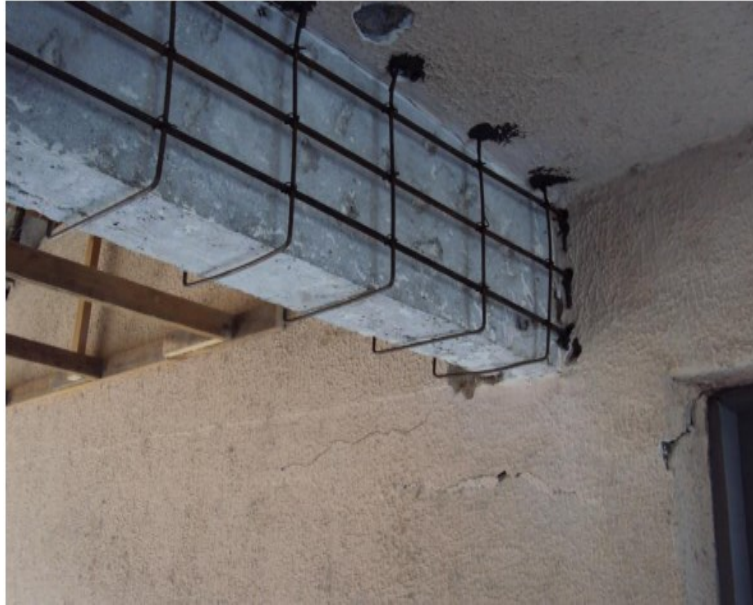
Figura 1: Viga sendo reforçada com adição de armadura
