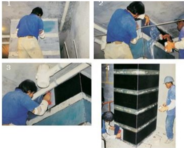
Figura 7: Aplicação de PRFC em pilar
