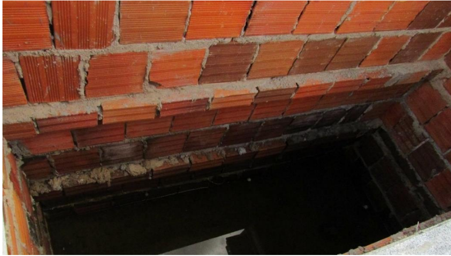
Figura 25: Parte interna de um jazigo em construção.
