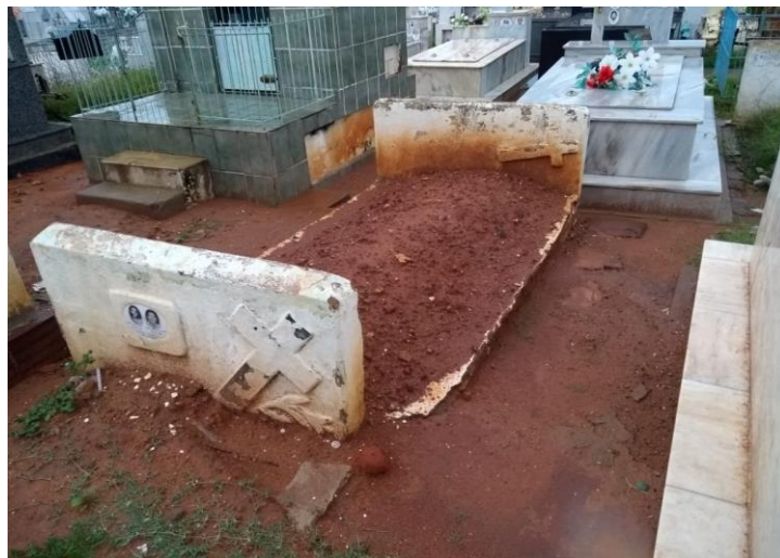
Figuras 53: Transporte de solo, decorrente da ação da chuva no cemitério São Manoel.
