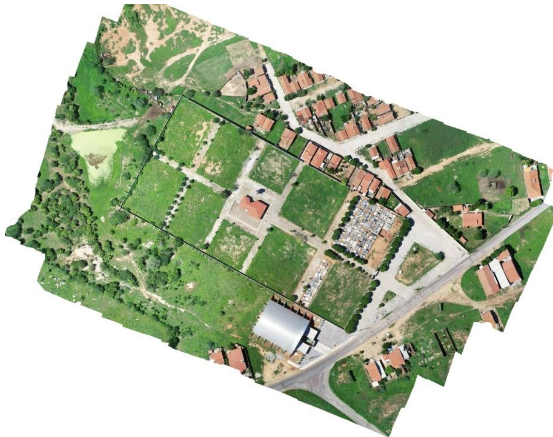
Figura 7: Vista superior do cemitério Parque da Saudade em Pau dos Ferros-RN.
