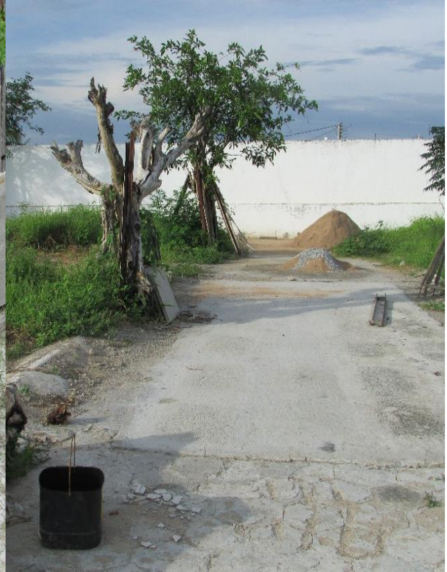
Figura 29: Materiais utilizados para a construção de jazigos.
