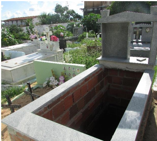
Figura 26: Etapa de construção de jazigo.
