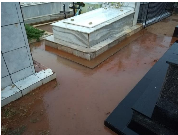
Figura 11: Área alagada no cemitério São Manoel após chuva.
