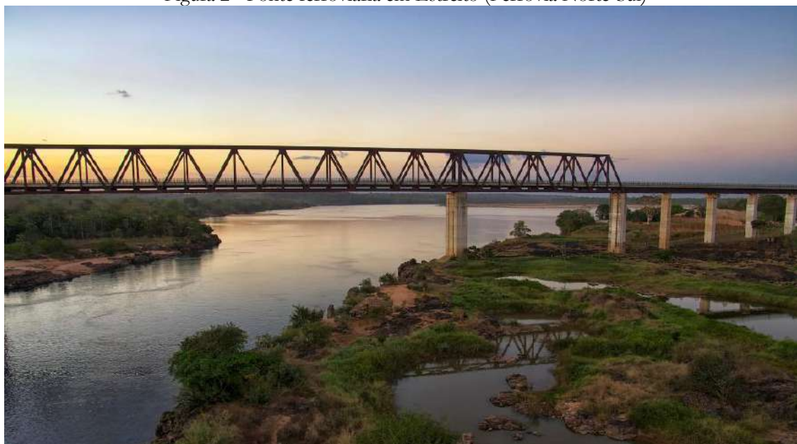
Figura 2 - Ponte ferroviária em Estreito (Ferrovia Norte-Sul)
