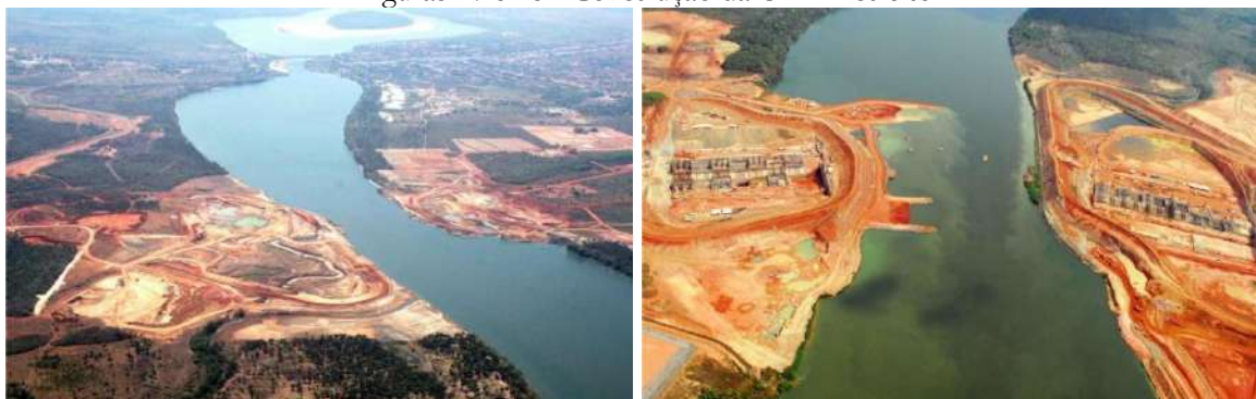
Figuras 17 e 18 - Construção da UHE Estreito
