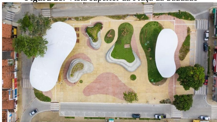
Figura 21: Vista superior da Praça da Saudade
