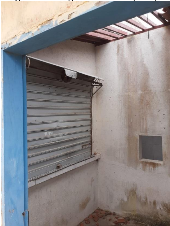
Figura 10: Imagem interna do quiosque
