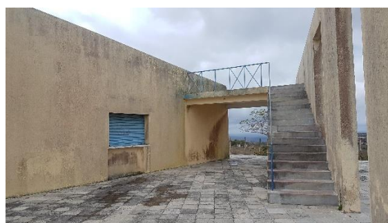
Figura 8: Estrutura do mirante
