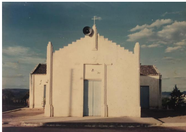
Figura 10 - Primeira versão da Capela de Nossa Senhora dos Milagres, construída em 1945.
