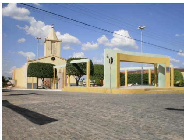
Figura 11 - Etapa intermediária de reforma da igreja.
