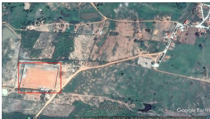
Figura 11 : Construção do estádio municipal de Água Nova/RN
