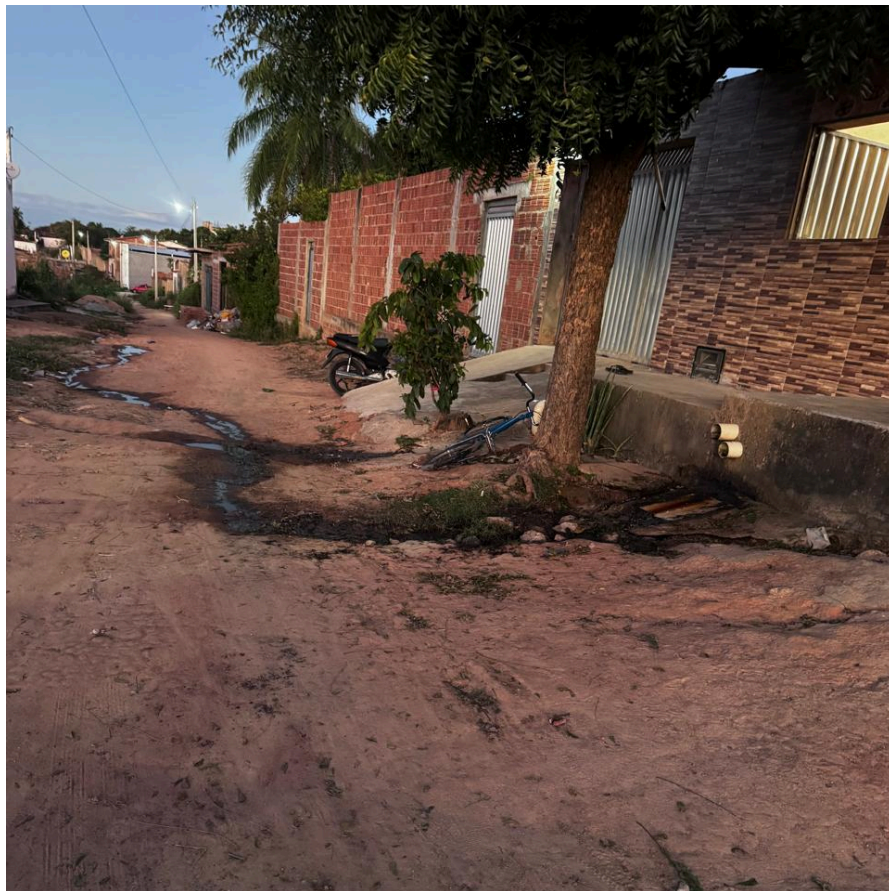
Figura 2 – Esgoto doméstico lançado em via pública em Luís Gomes/RN.
