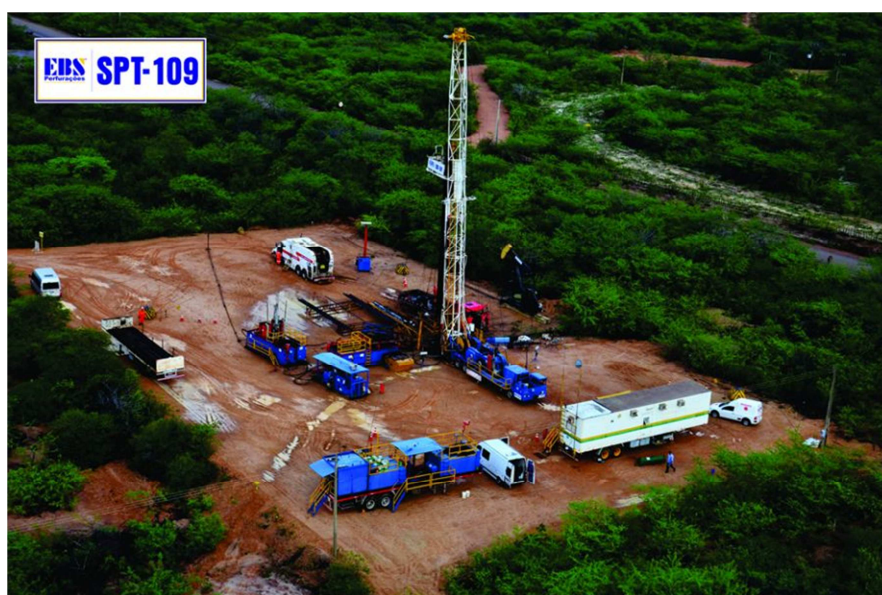
Figura10 – Vista aérea de uma locação com SPT operando.
