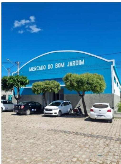
Figura 3: Vista da frente do mercado públicos Antônio Ferreira de Sousa, mercado do Bom Jardim de Mossoró/RN.
