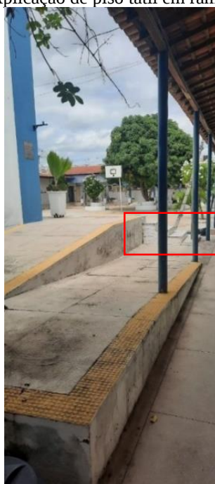
Figura 27- Aplicação de piso tátil em rampa 2 em IES 1
