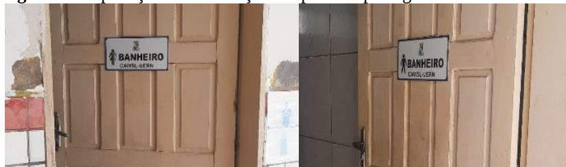
Figura 32- Aplicação de sinalização em portas e passagens - Banheiros
