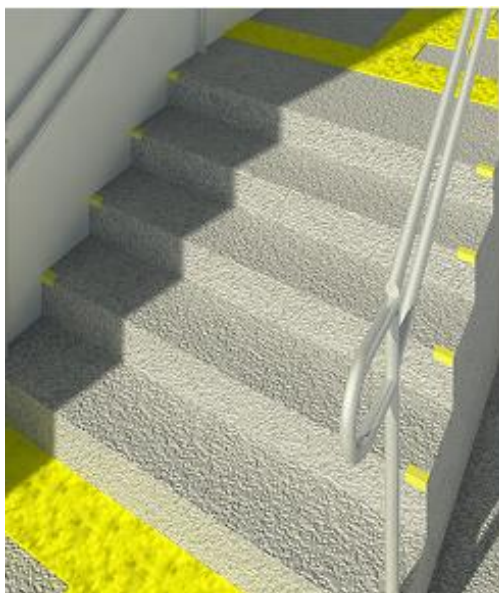
Figura 25- Modelo de proposta de aplicação de sinalização em escada
