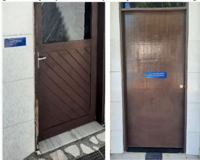
Figura 40- Aplicação de sinalização em porta na IES 2 – imagem 1
