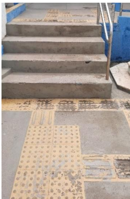
Figura 24- Aplicação de piso tátil em escada em IES I
