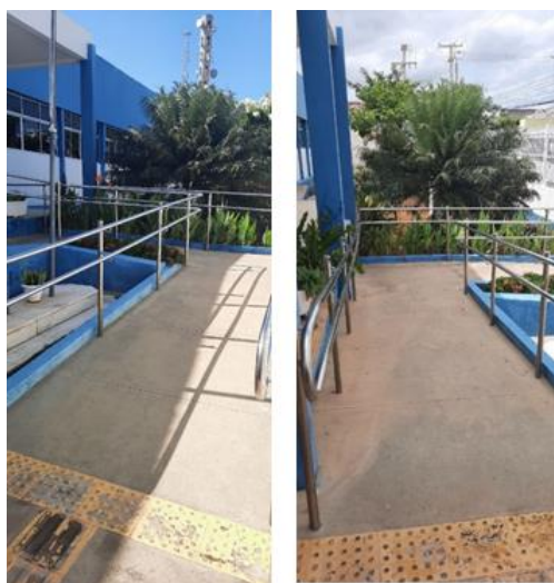
Figura 26- Aplicação de piso tátil em rampa 1 em IES 1
