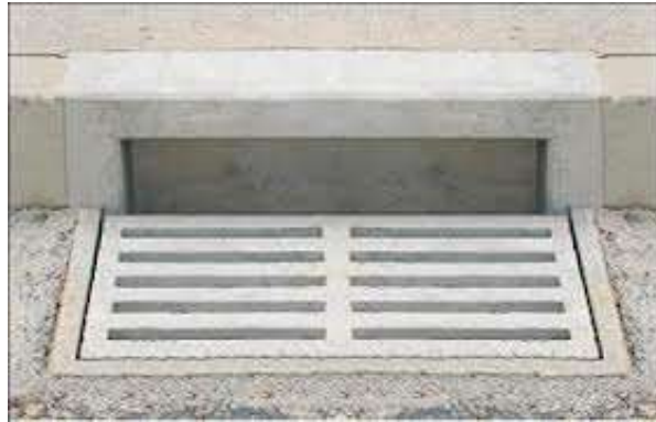
Figura 28: Boca de lobo com grelha
