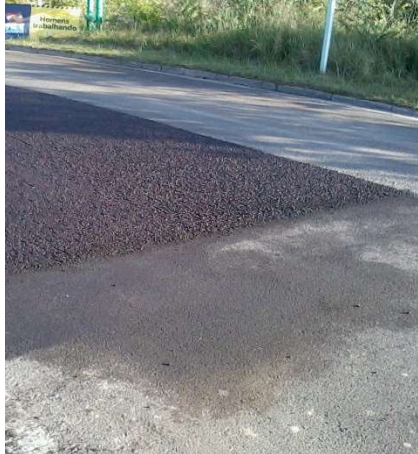
Figura 23: Remendo superficial
