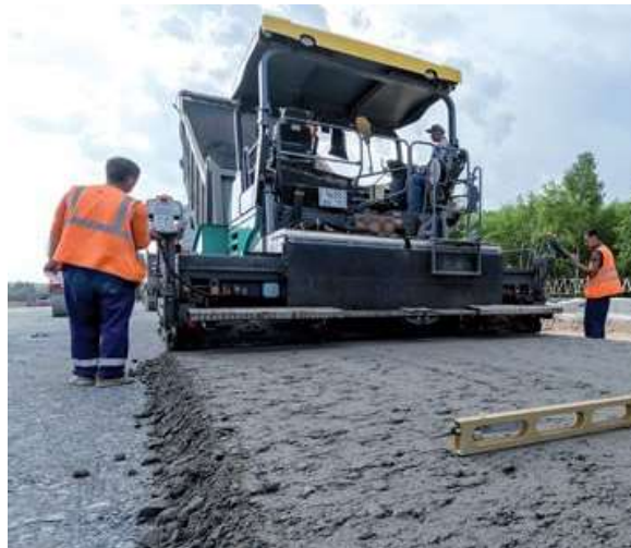
Figura 18: Camada de reforço
