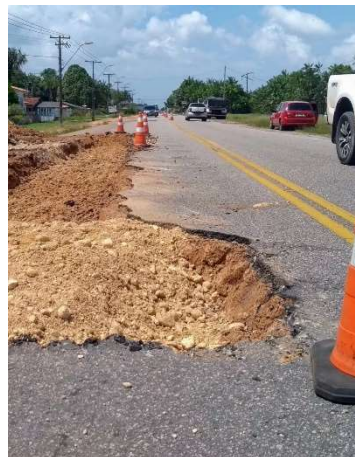
Figura 24: Remendo profundo
