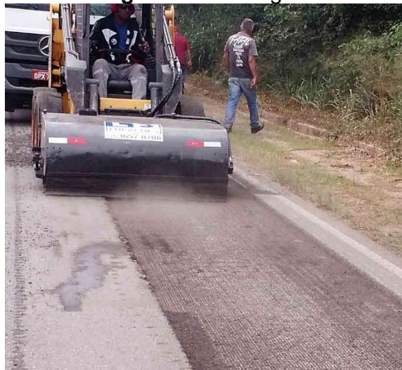
Figura 19: Fresagem
