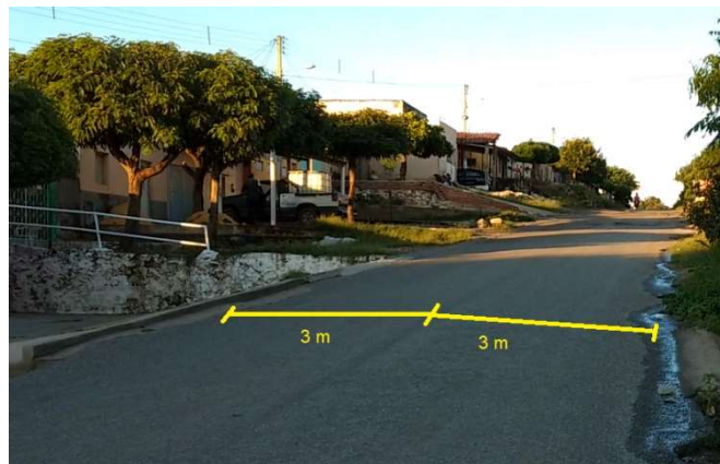
Figura 39: Dimensões transversal da Rua Antônio Gurjão
