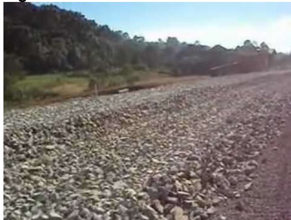
Figura 05: Base de Macadame Hidráulico
