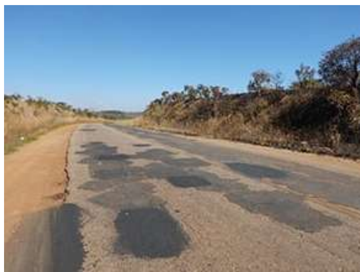
Figura 16: Remendo no Pavimento asfáltico
