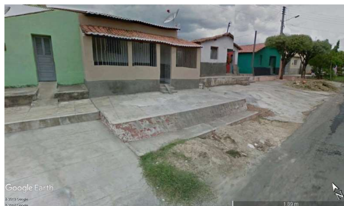
Figura 36: Talude impermeabilizado
