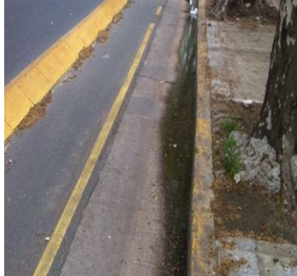
Figura 26: Sarjeta Lateral
