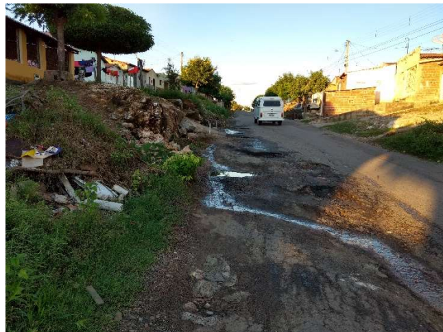
Figura 32: Esgoto a céu aberto
