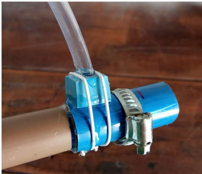
Figura 20: Tomada de pressão finalizada.
