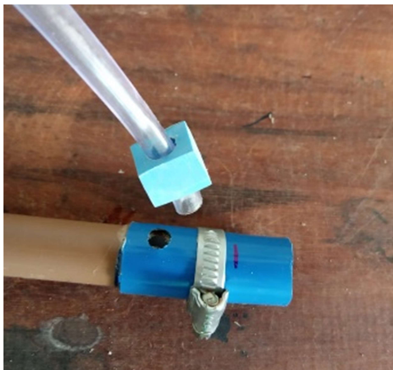
Figura 19: Bucha plástica em PVC usada para fixação das mangueiras piezométricas.
