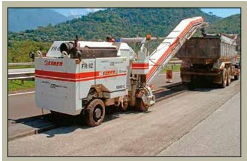
Figura 4: Processo de fresagem e recolhimento do material.
