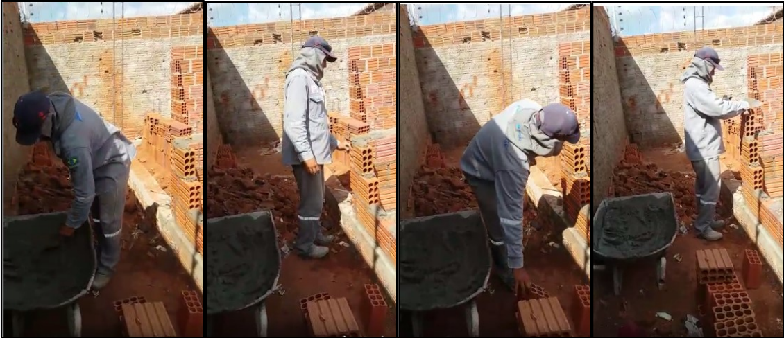
Figura 9. Sequência de passos do pedreiro.
