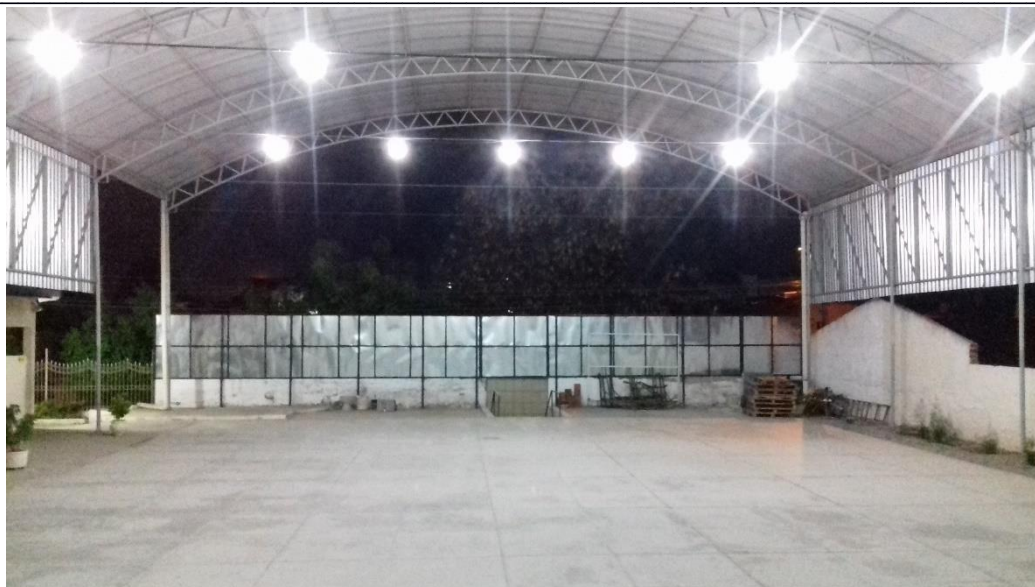
Figura 10. Início da quadra (Autoria própria)
