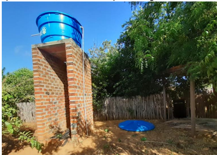
Figura 2 - Três componentes principais do reuso de águas cinzas. Da direita para esquerda: filtro, reservatório pós-filtragem e reservatório final.
