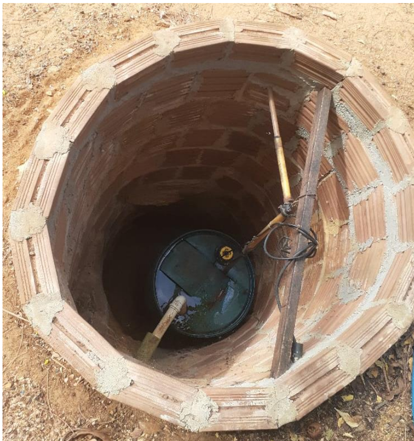
Figura 3 - Vista superior do reservatório pós-filtragem.
