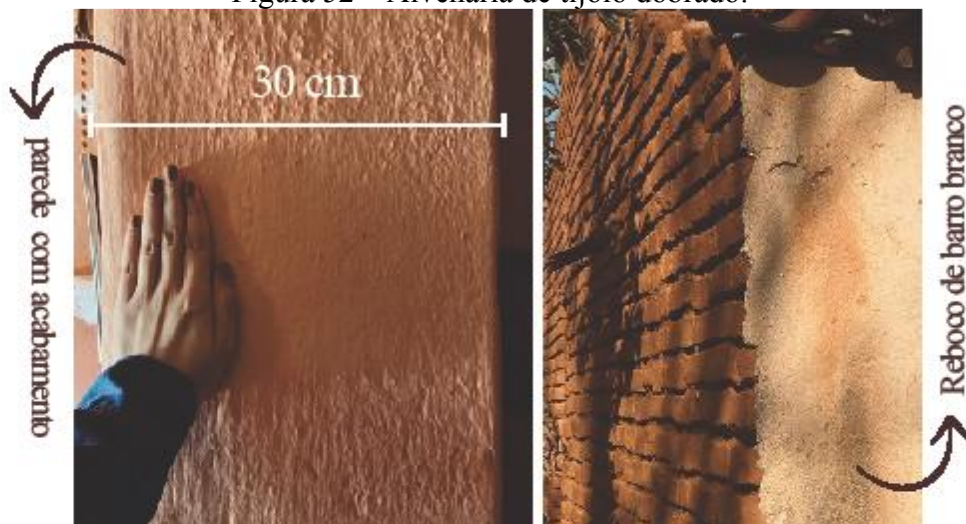
Figura 52 – Alvenaria de tijolo dobrado.
