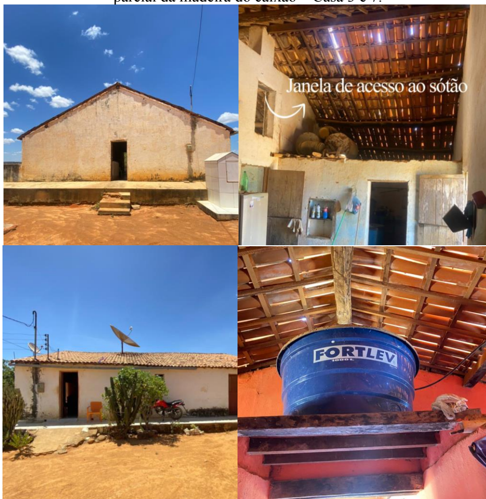
Figura 79 – Casa com Sótão com estrutura do caixão ausente; sótão com estrutura parcial da madeira do caixão – Casa 3 e 7.
