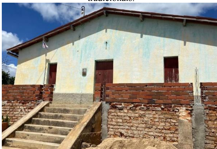
Figura 12 – Construção de alpendre com justaposição de materiais industriais sob os tradicionais.
