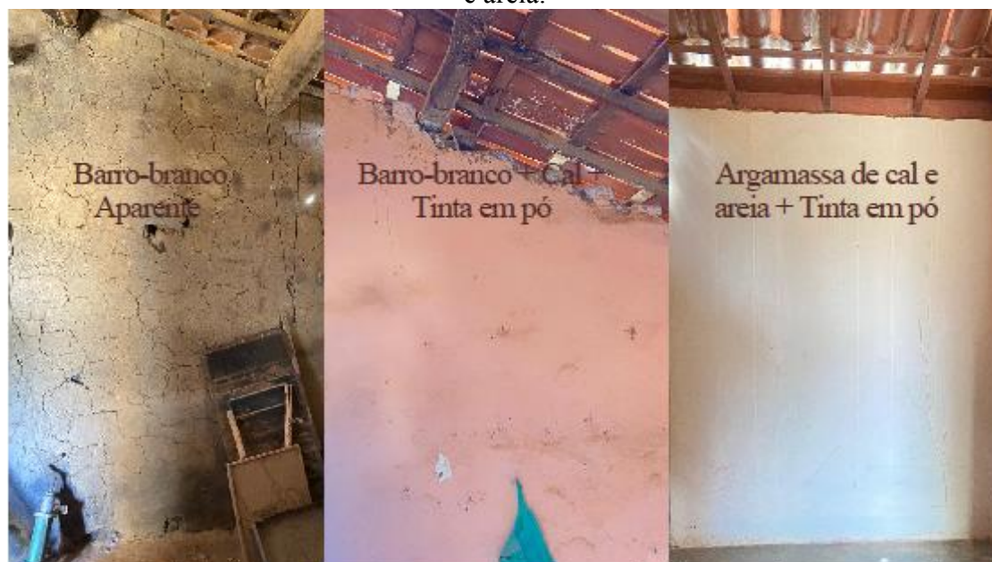
Figura 84 – Alvenarias com revestimento de Barro - branco e Argamassa de cal e areia.
