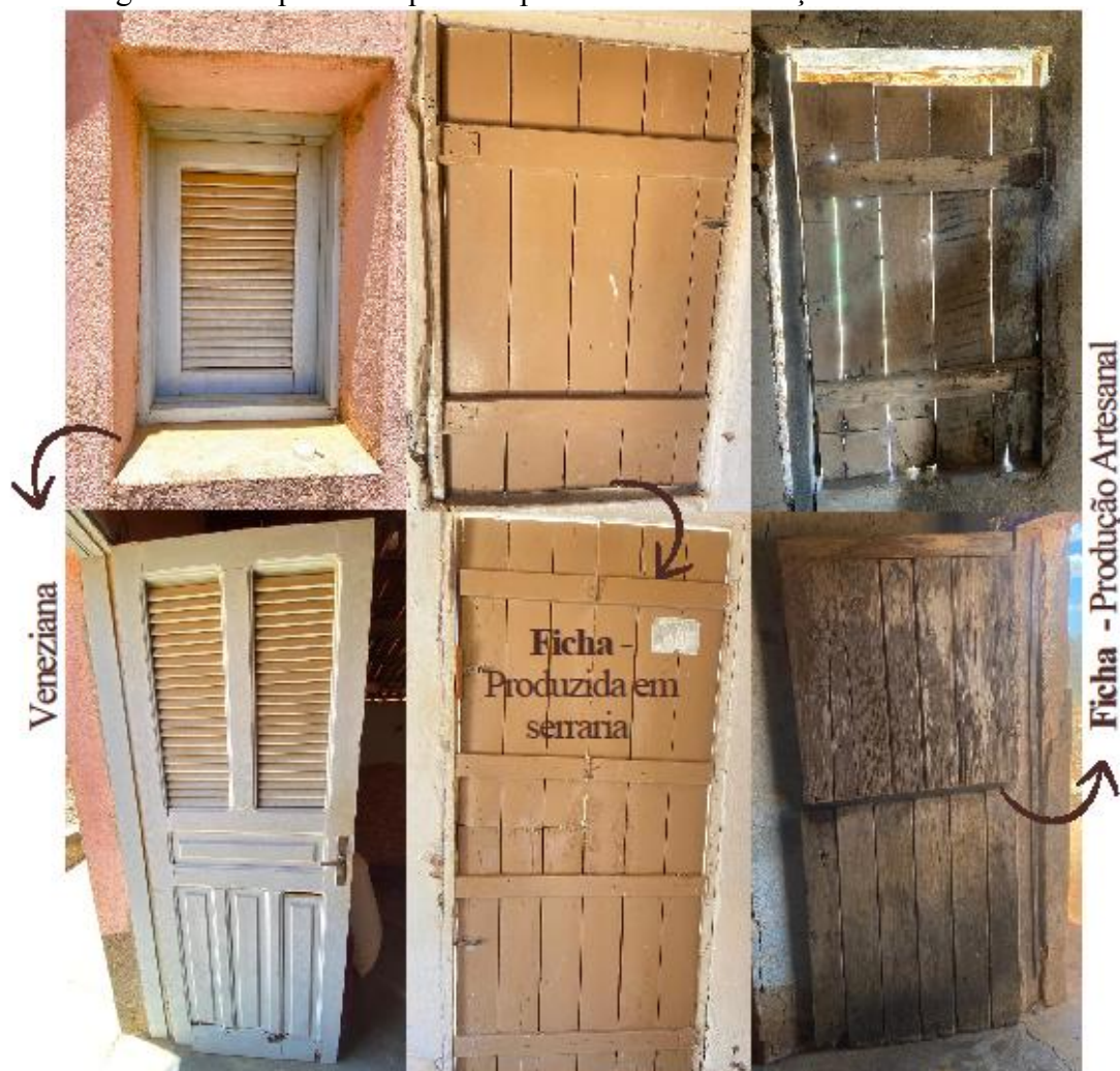
Figura 87 – Tipos de esquadrias presentes nas edificações inventariadas.
