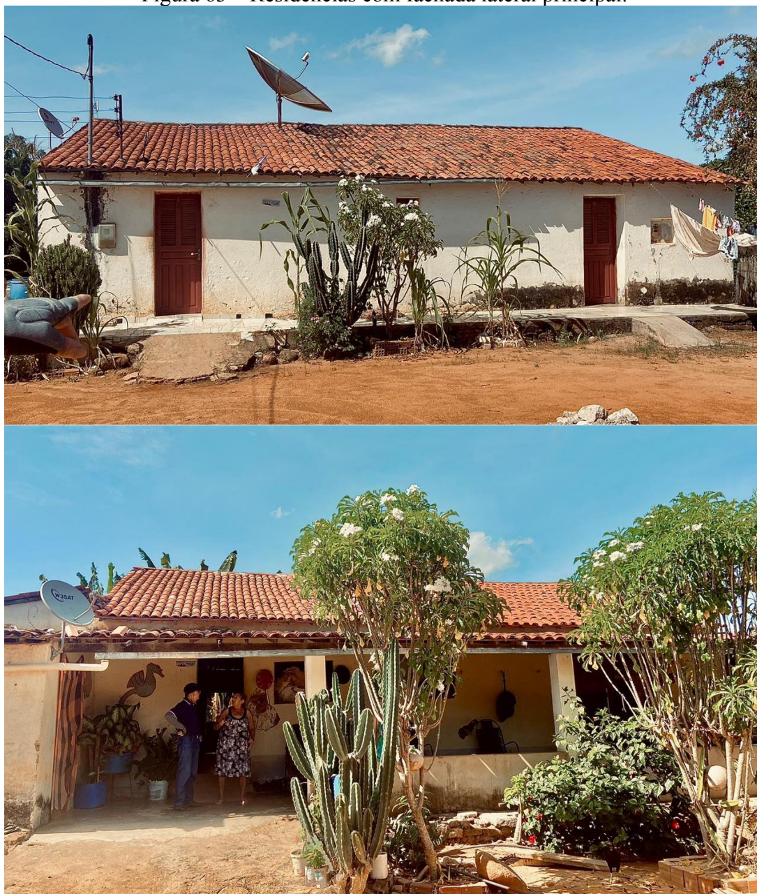
Figura 63 – Residências com fachada lateral principal.
