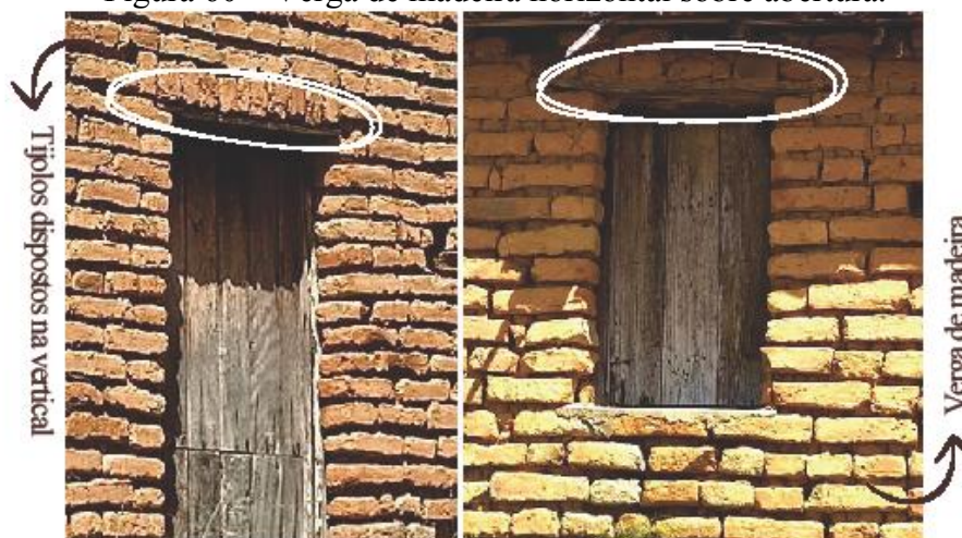
Figura 60 – Verga de madeira horizontal sobre abertura.
