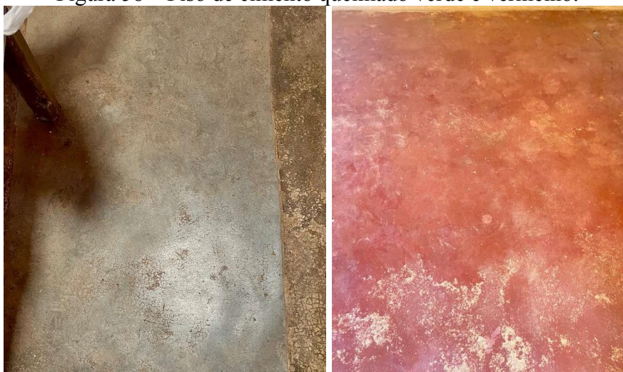
Figura 58 – Piso de cimento queimado verde e vermelho.
