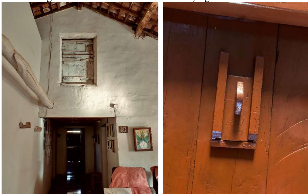
Figura 76 – Janelas de acesso ao sótão; e gaveta do caixão.
