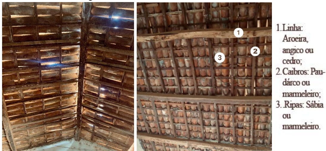
Figura 53 – Estrutura de madeira do telhado.
