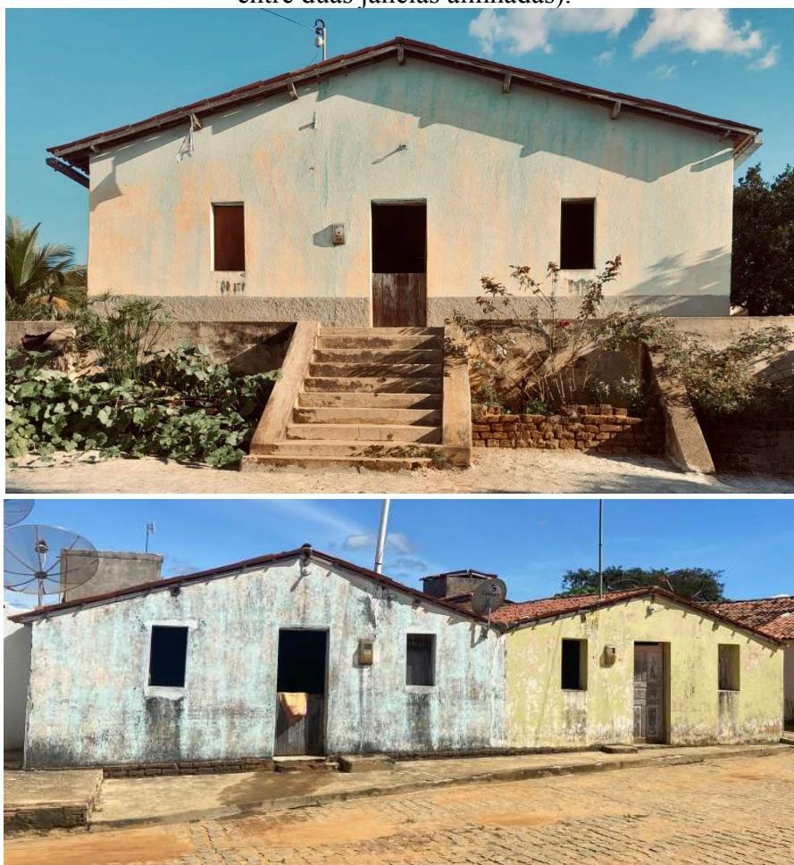
Figura 66 – Padrão de organização das esquadrias na fachada frontal (porta centralizada entre duas janelas alinhadas).
