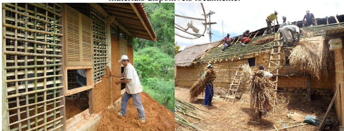
Figura 2 – Construção de residências com técnicas construtivas tradicionais e uso de materiais disponíveis localmente.
