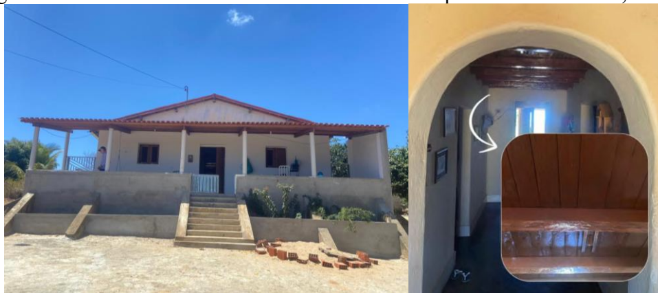
Figura 78 – Casa com sótão com estrutura do caixão preservada – Casa 1, 2 e 10.
