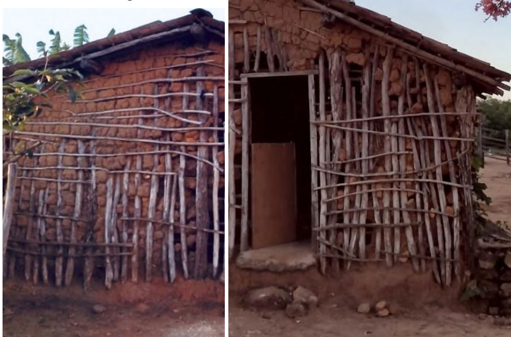
Figura 43 – Alvenaria de taipa de mão, 2025.
