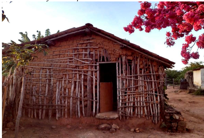
Figura 62 – Telhado de duas águas com cumeeira perpendicular a via/Fachada em residências tradicionais da comunidade: Casa de taipa; casa de alvenaria mista - adobe e tijolo maciço sem reboco e com reboco.
