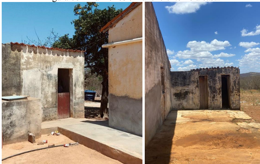
Figura 68 – Banheiros em anexo externo a casa.
