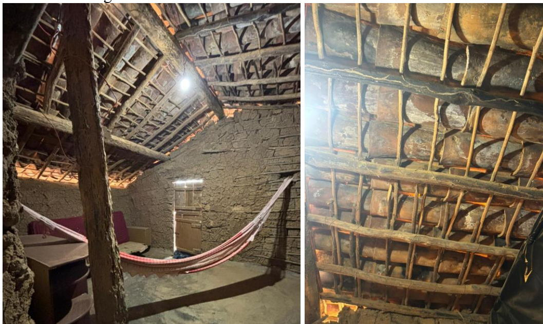
Figura 90 – Cobertura com estrutura de madeira natural.
