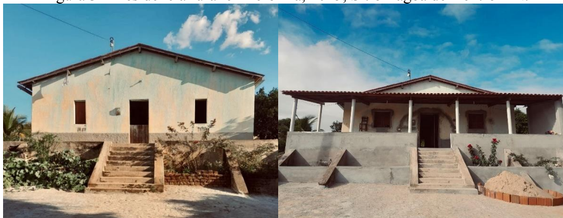
Figura 3 – Residência rural em reforma, 2025, Sítio Lagoa de Dentro-RN.
