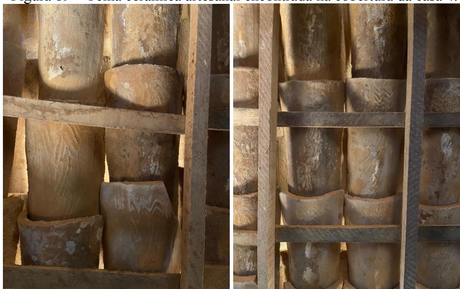
Figura 89 – Telha cerâmica artesanal encontrada na cobertura da casa 4.
