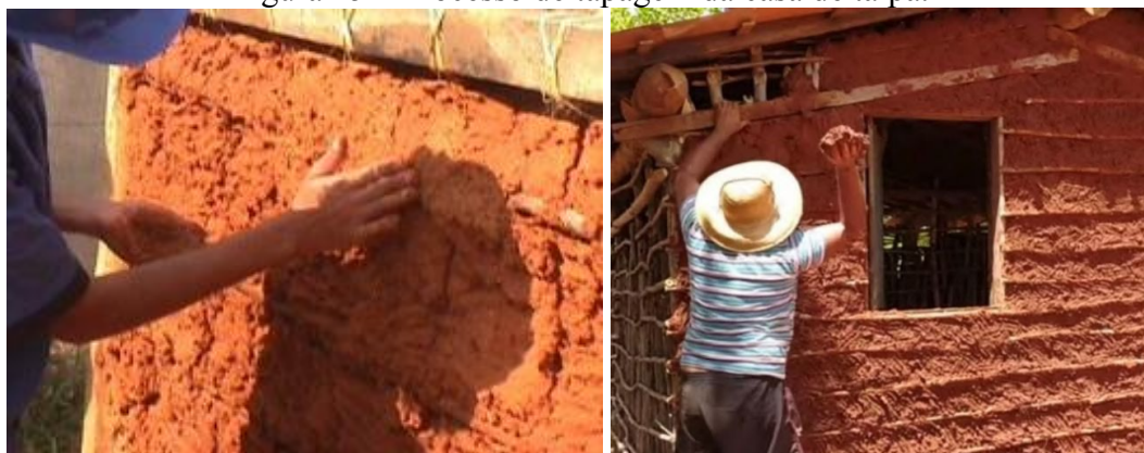
Figura 45 – Processo de tapagem da casa de taipa.
