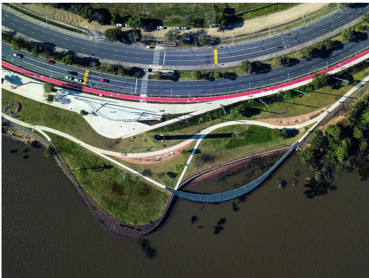
Figura 14: Vista aérea da área de intervenção do trecho I.
