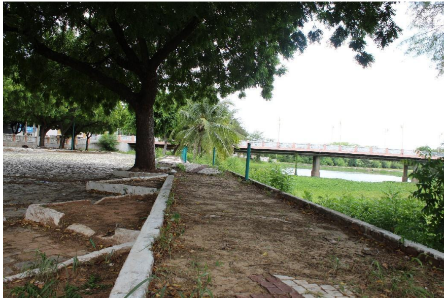
Figura 28: Situação passeio do estacionamento.
