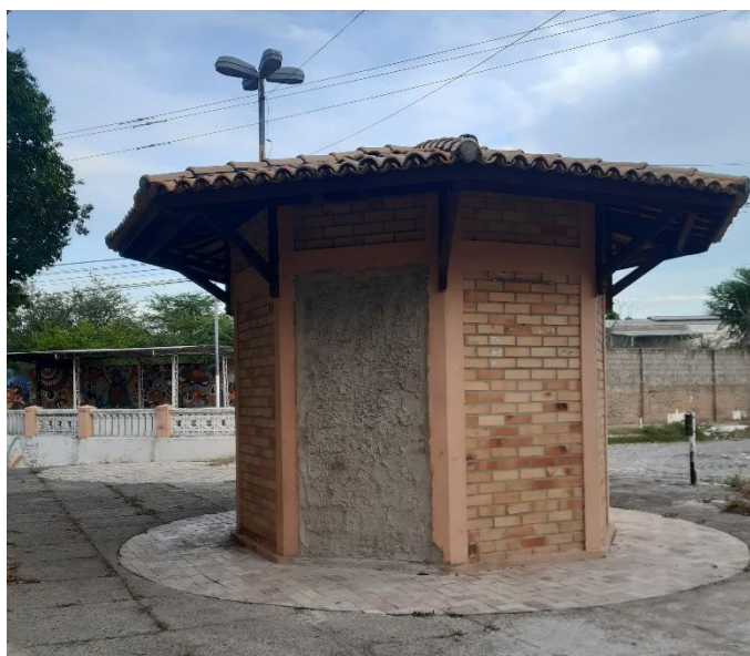
Figura 39: Situação de um dos quiosques.
