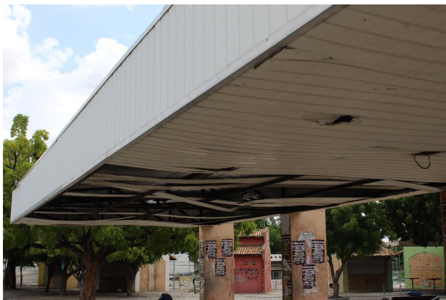
Figura 43: Situação da estrutura do terminal.
