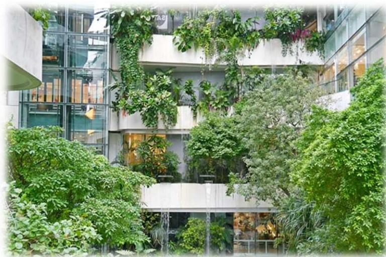
Figura 17 - Cobertura verde, a biofilia e o conforto térmico ressonam
